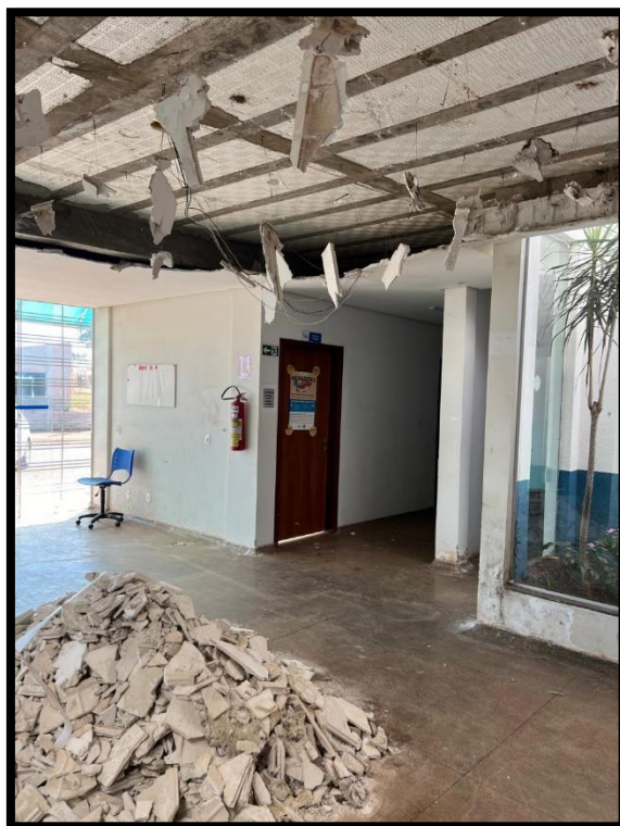
Figura 3- Retirada do forro e medição da laje
