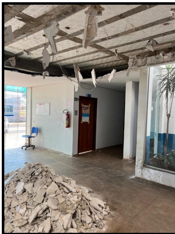
Figura 3- Retirada do forro e medição da laje
