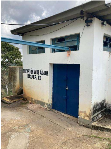
Figura 43 - Estação Elevatória de Água Bruta 2 (EEAB2 – Palmital) (vista 1)
