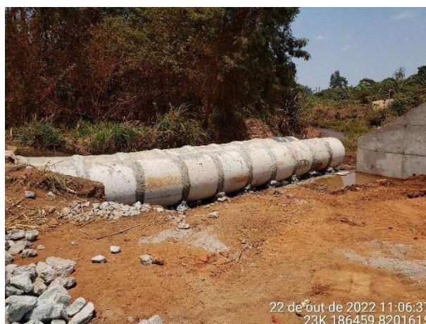
Figura 127 - Obra de construção/substituição de galerias em andamento
