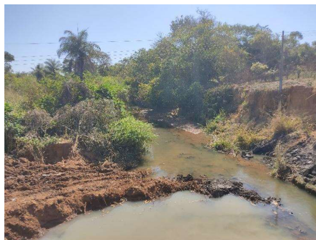
Figura 71 - Processo erosivo Rio Vermelho
