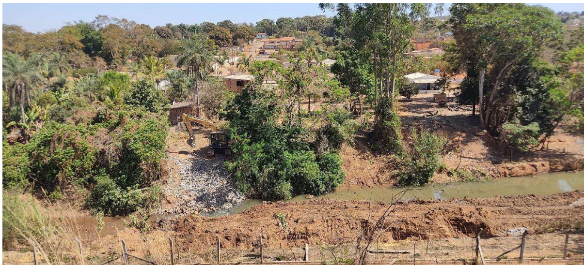
Figura 72 - Máquinas trabalhando na contenção de processo erosivo no Rio Vermelho
