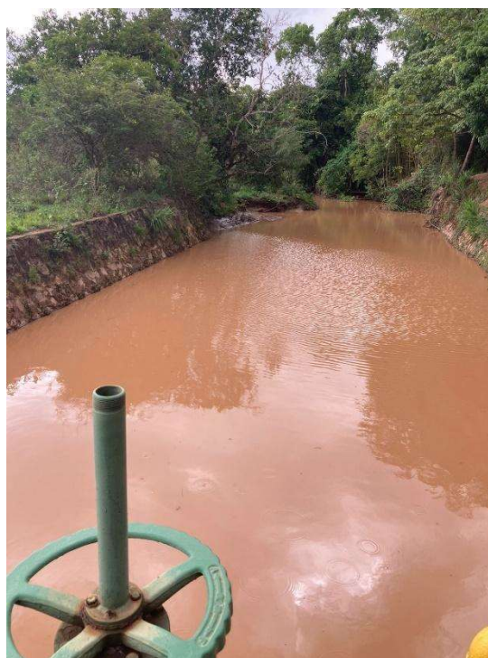
Figura 41 - Local de Captação Córrego Palmital (vista 2)
