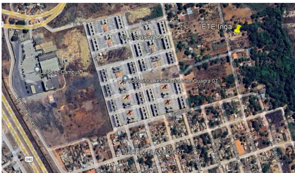
Figura 67 - Estação de Tratamento de Esgoto Ingá
