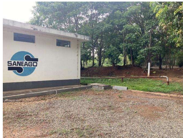
Figura 39 - Poço Tubular Profundo da Captação Palmital
