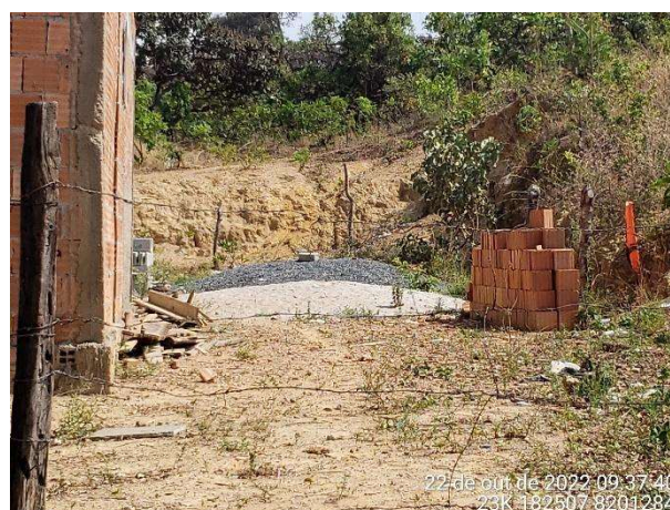
Figura 121 - Processo erosivo às margens de residências
