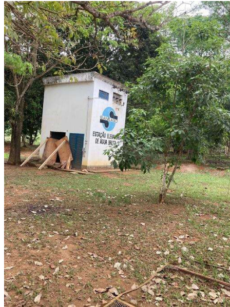
Figura 42 - Estação Elevatória de Água Bruta 1 (EEAB1 – Palmital)
