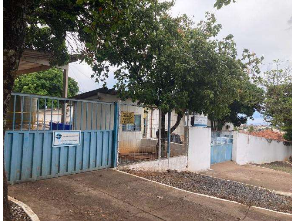
Figura 46 - Acesso ETA Natal de Lima
