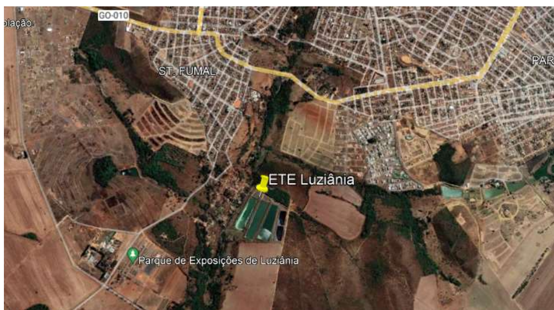
Figura 66 - Estação de Tratamento de Esgoto Luziânia
