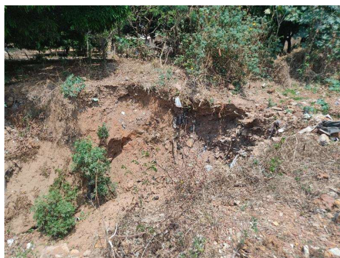
Figura 117 - Processo erosivo próximo a residências
