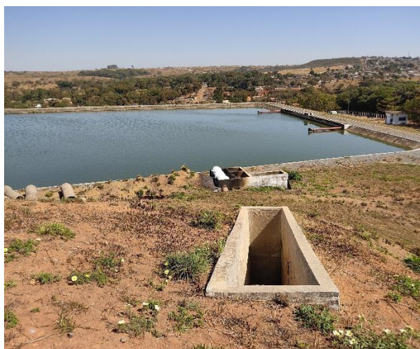
Figura 68 - Lagoa Anaeróbica
