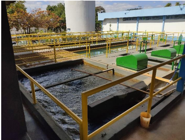
Figura 48 - Processo de cloração inicial ETA Natal de Lima
