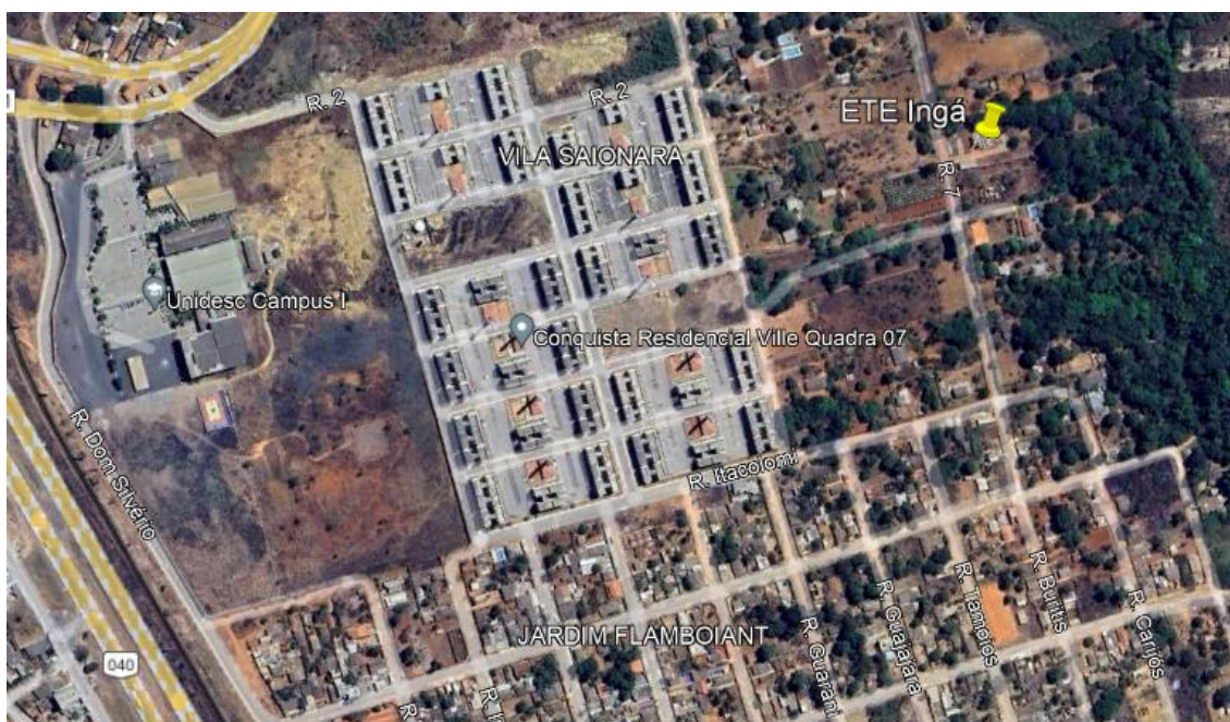
Figura 67 - Estação de Tratamento de Esgoto Ingá
