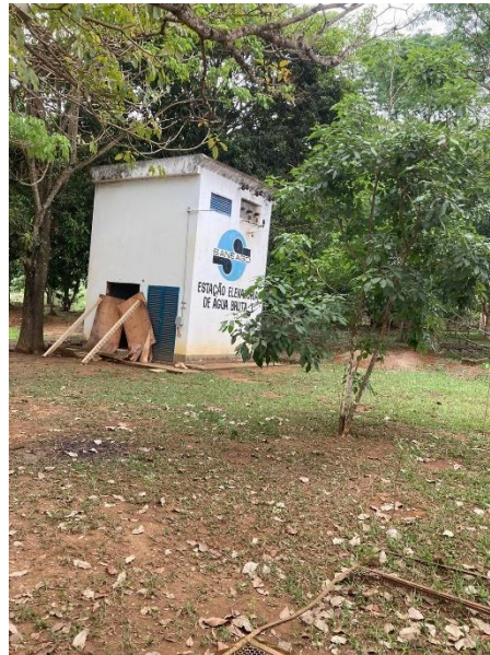
Figura 42 - Estação Elevatória de Água Bruta 1 (EEAB1 – Palmital)
