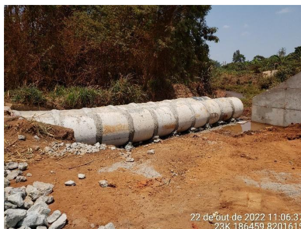
Figura 127 - Obra de construção/substituição de galerias em andamento
