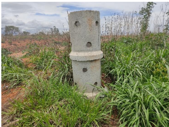
Figura 100 - Área encerrada do lixão (vista 1)
