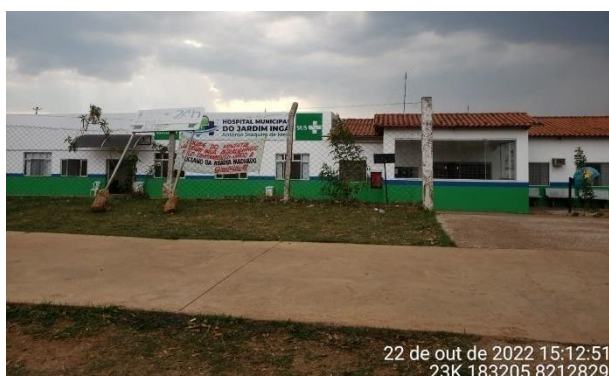
Figura 31 - Hospital Municipal do Jardim Ingá
