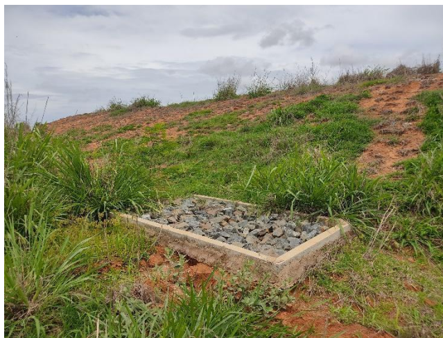
Figura 101 - Área encerrada do lixão (vista 2)
