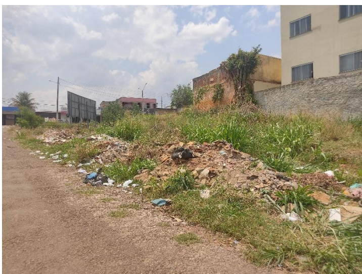
Figura 93 - Descarte irregular de RCC às margens da via
