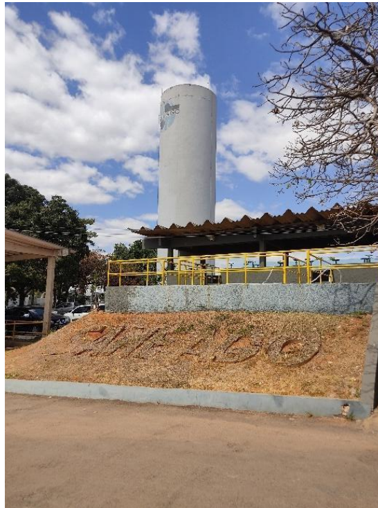
Figura 52 - Reservatórios ETA Natal de Lima
