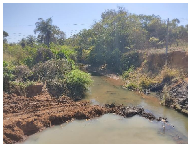
Figura 71 - Processo erosivo Rio Vermelho
