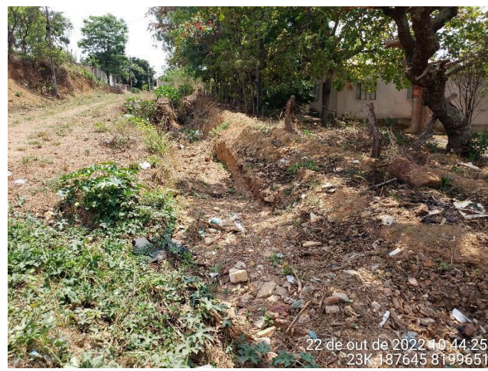
Figura 119 - Aparente serviço de aterro com RCC, para conter processo erosivo, sendo carreado
