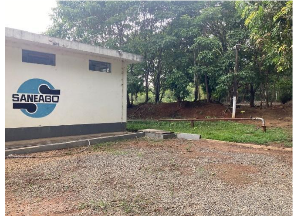
Figura 39 - Poço Tubular Profundo da Captação Palmital
