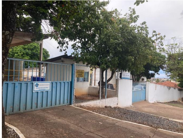
Figura 46 - Acesso ETA Natal de Lima
