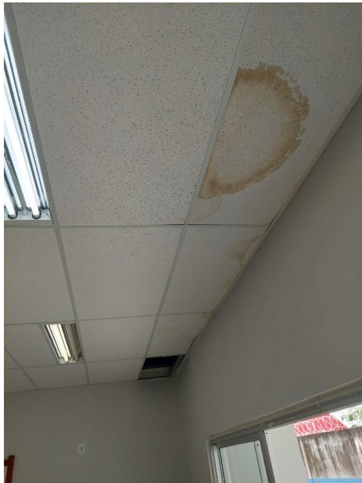
Imagem 05: Exemplo de forros a serem substituídos e instalados
