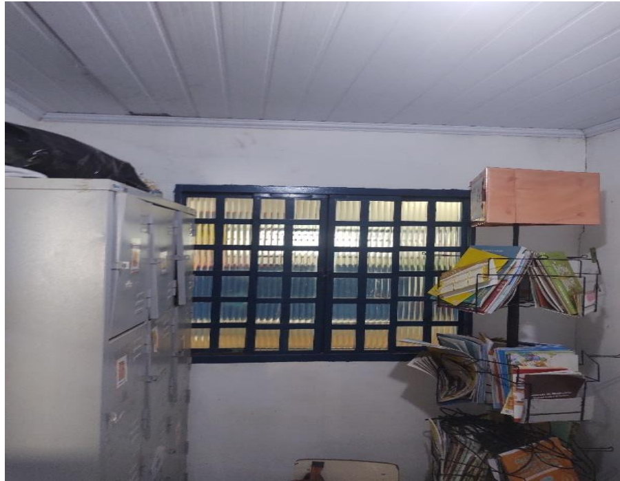
Locais onde serão feitas revisão de forro
