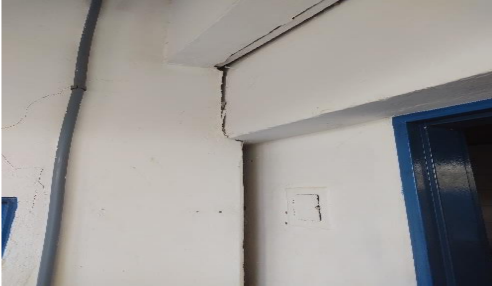
Junta de dilatação entre varanda e cozinha
