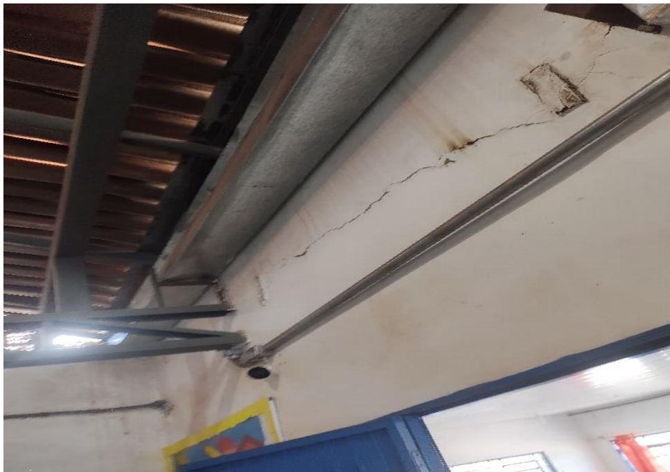
Rachadura viga
