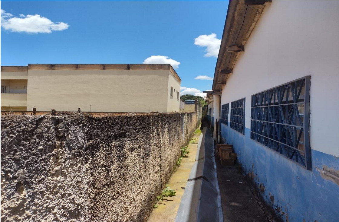
Calçada a ser demolida e reconstruída
