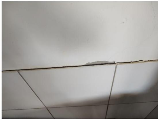
**Imagem 06: Exemplo de revestimento cerâmico a ser substituído**
