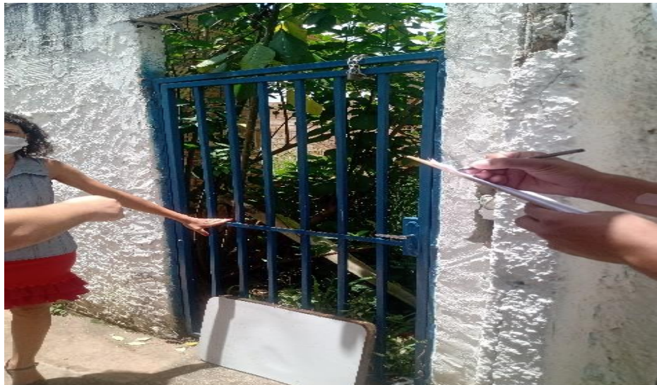
Acesso – fechamento com alvenaria.
