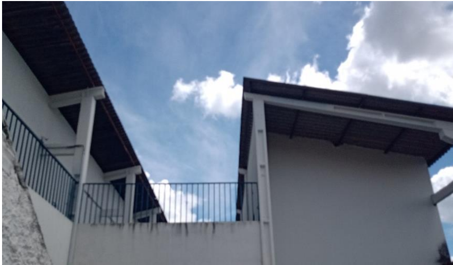
Cobertura pátio central superior
