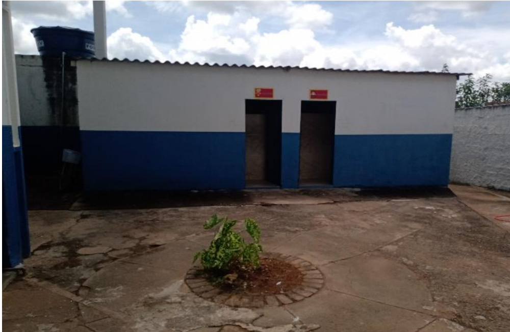
Cobertura em frente Banheiro Térreo
