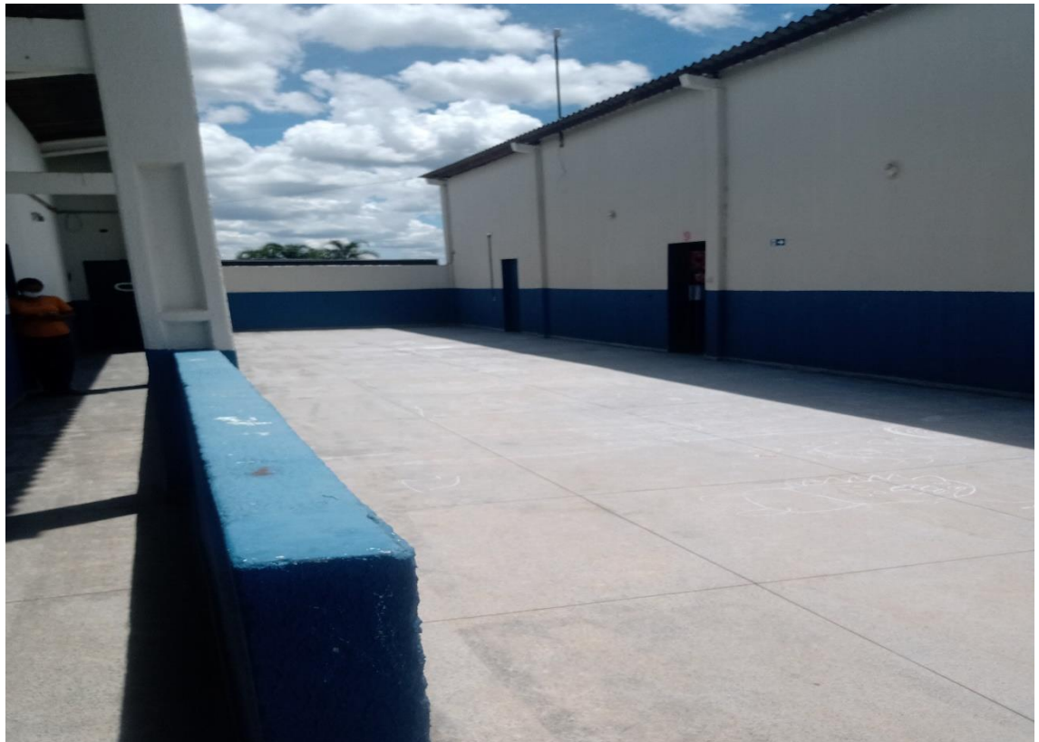
Cobertura do pátio superior
