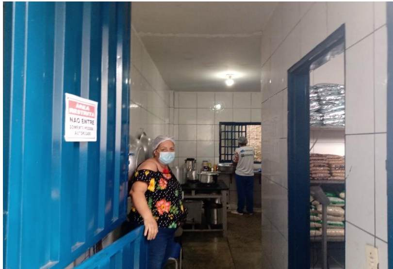
Revestimento cerâmico das paredes internas da cozinha a serem removidos
