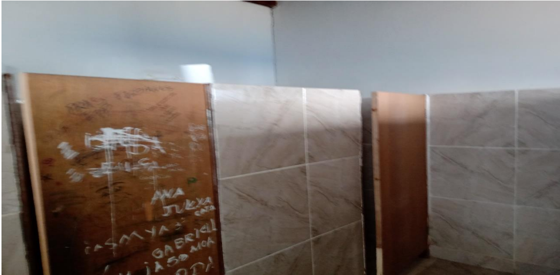
Pintura das portas do box dos banheiros térreo
