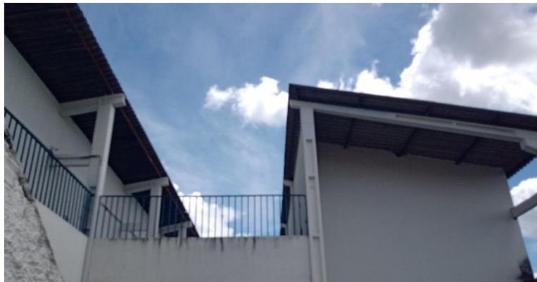
Imagem 01: Telhado principal da escola – blocos de sala de aula.
