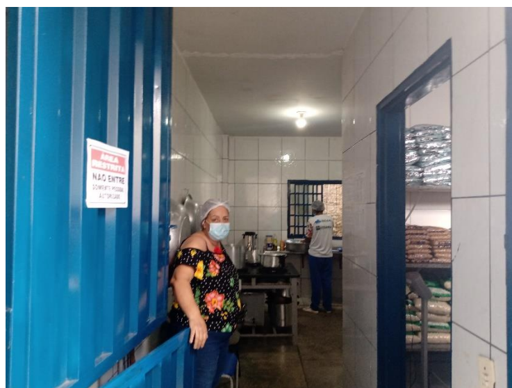
Imagem 05: Piso da antiga cozinha a ser removido.
