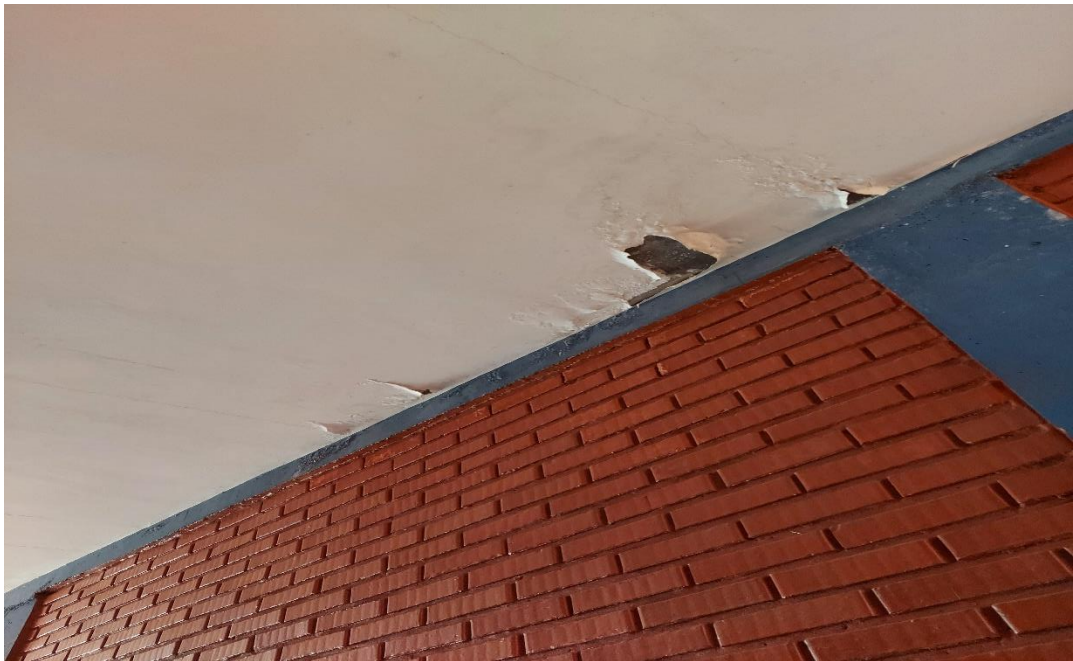
Infiltração teto
