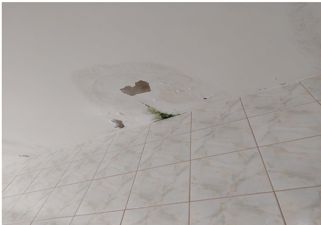
Infiltração teto
