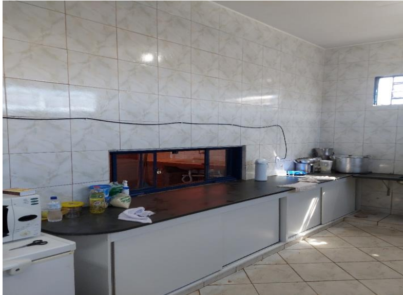
Revestimento cerâmico da cozinha
