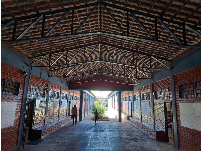
Telhado da escola.
