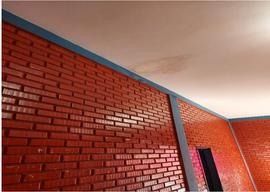
Infiltração teto
