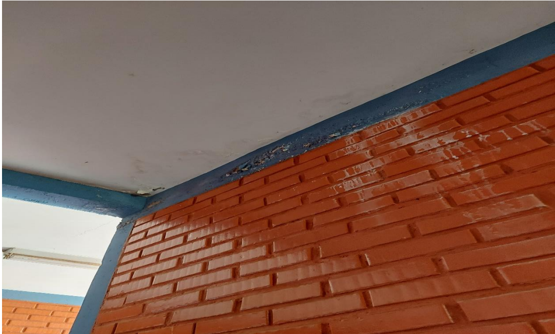
Infiltração teto
