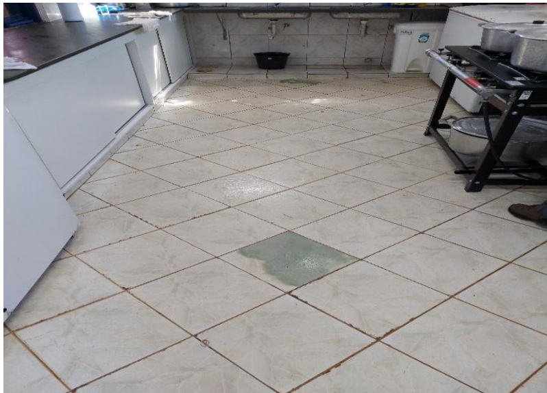
Piso da cantina.
