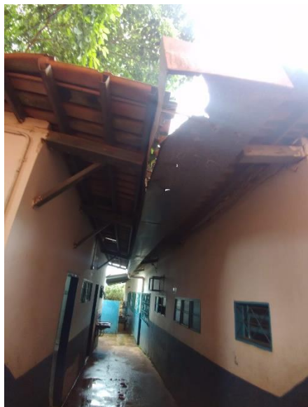
Imagem 09: Exemplo de calhas que devem ser tratadas
