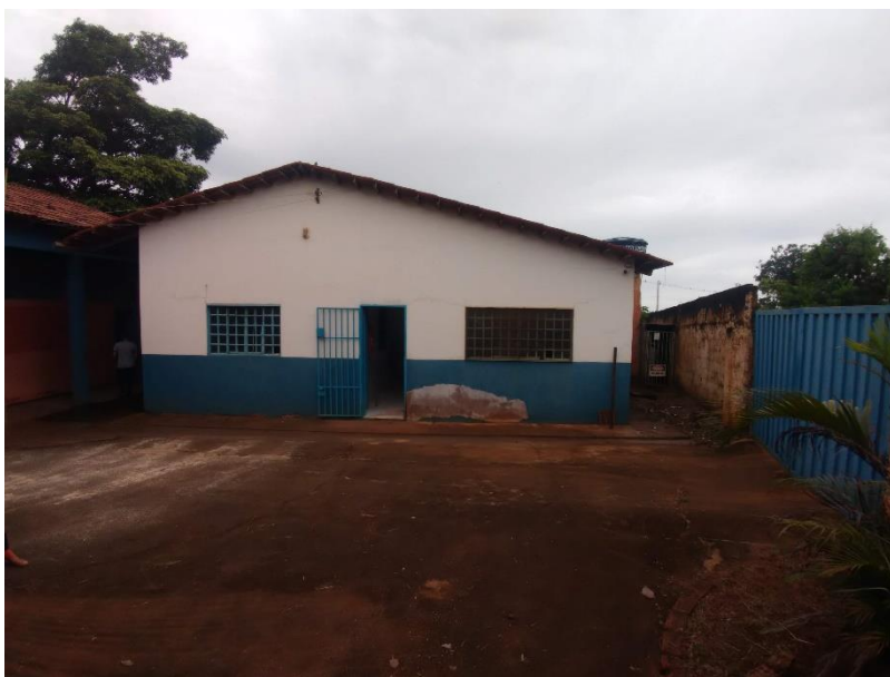
Imagem 04: Acesso à cozinha
