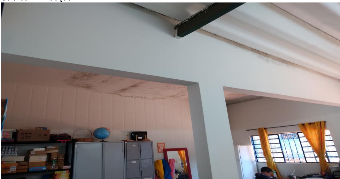
Infiltração - instalação de forro de PVC com estrutura metálica
