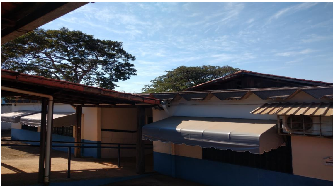
Substituição de calha
