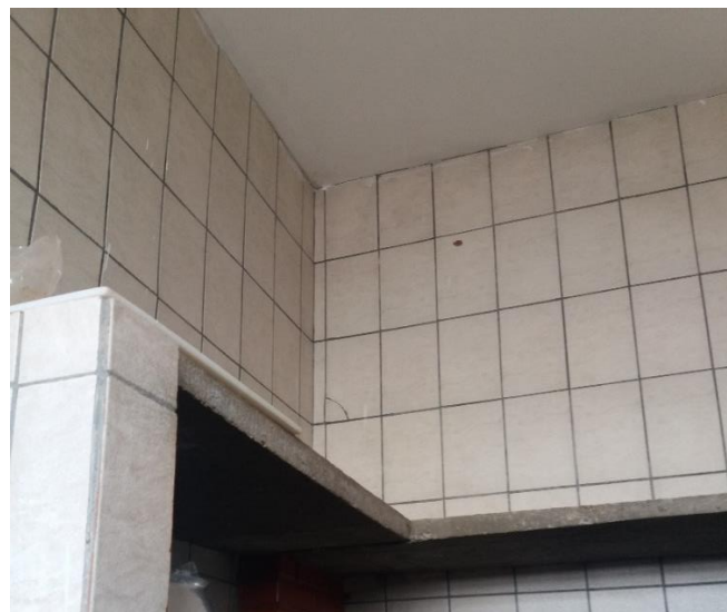
Imagem 04: Revestimento cerâmico da despensa 01.
