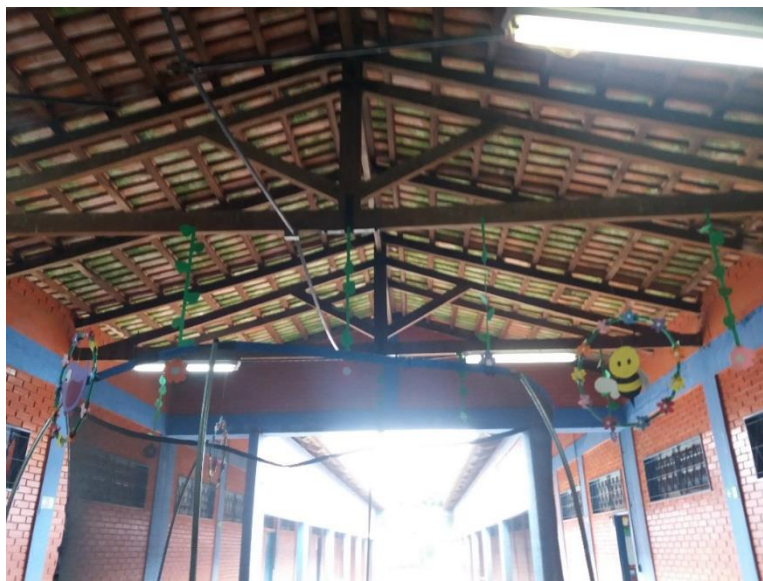
Imagem 01: Telhado da escola.
