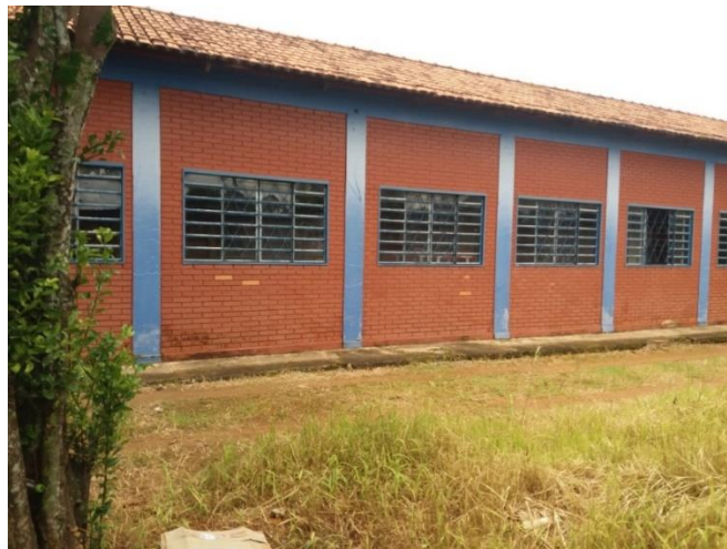
Imagem 05: Exemplo de parede, pilar e viga.
