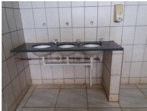
Imagem 11: Lavatório do banheiro feminino.
