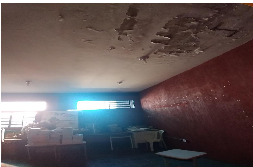
Infiltração teto
