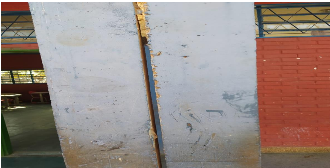
Reparo na junta de dilatação entre os pilares
