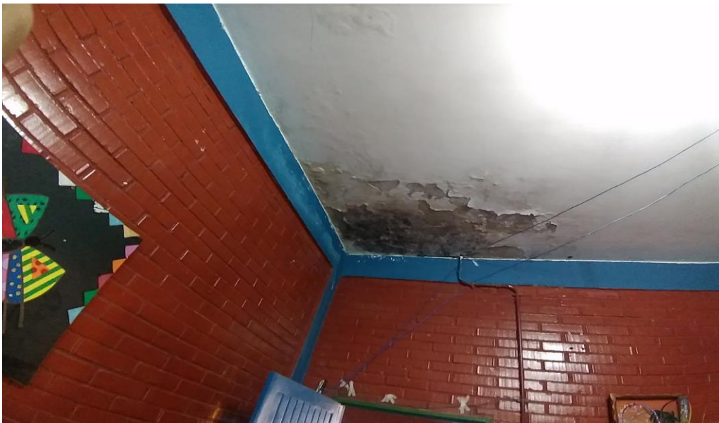
Infiltração teto
