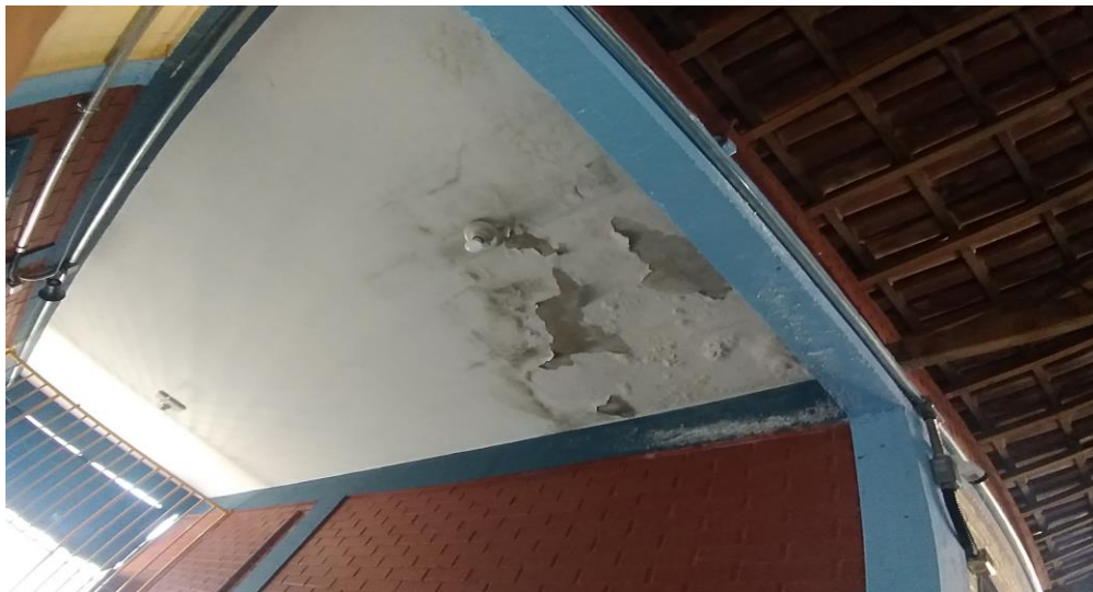
Infiltração teto
