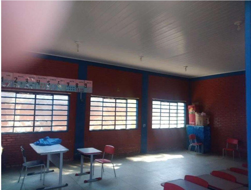
Figura 08: Exemplo interno de parede, pilar e viga
