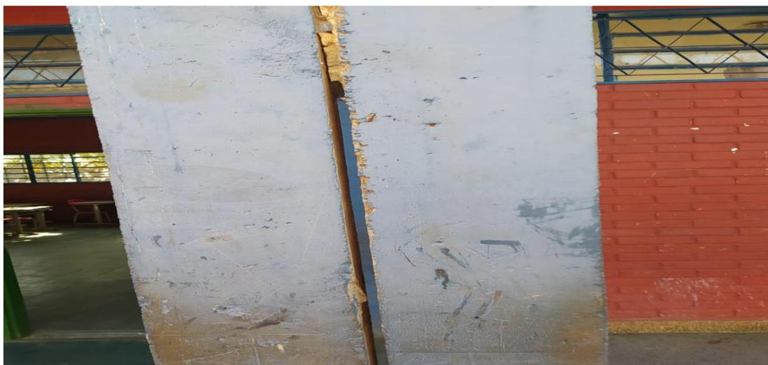
Reparo na junta de dilatação entre os pilares
