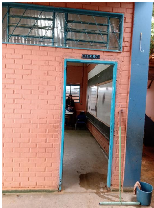
Imagem 06: Exemplo de parede a ser pintada
