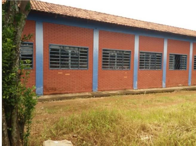
Imagem 05: Exemplo de parede, pilar e viga.
