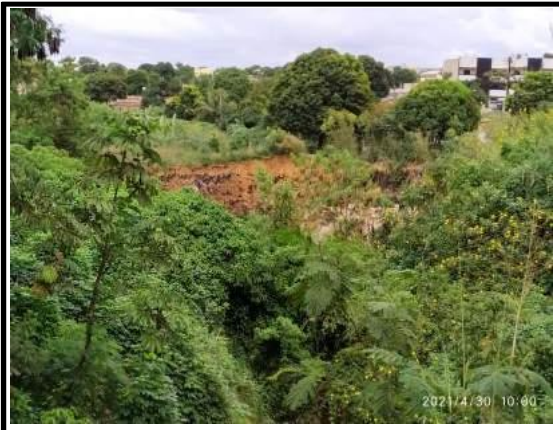
AVANÇO PROCESSO EROSIVO
