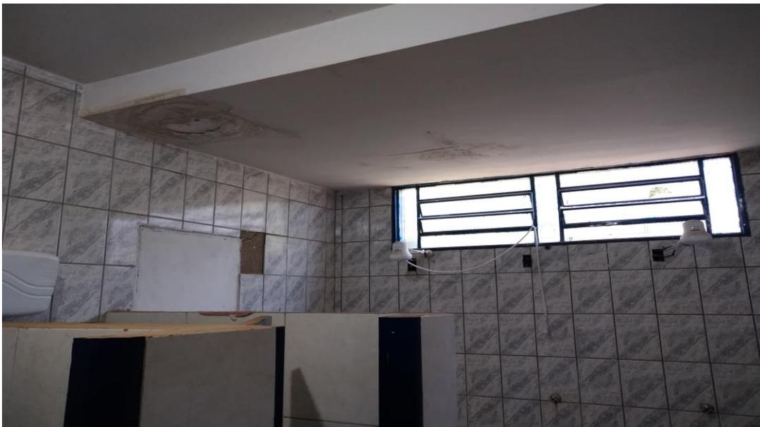
Infiltração, cerâmica quebrada
