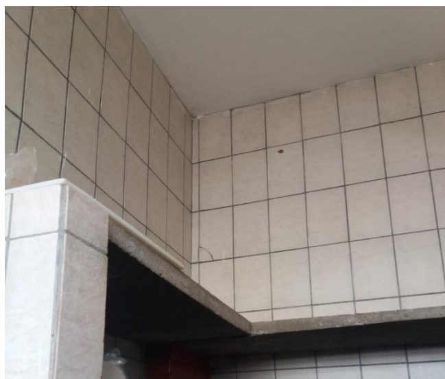
Imagem 04: Revestimento cerâmico da despensa 01.
