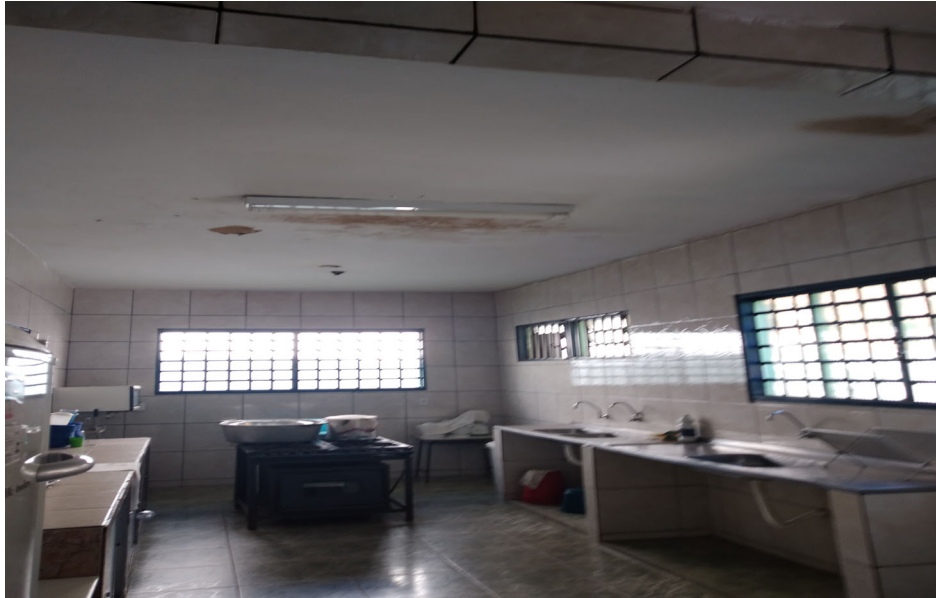
Imagem 03: Infiltração teto cozinha.
