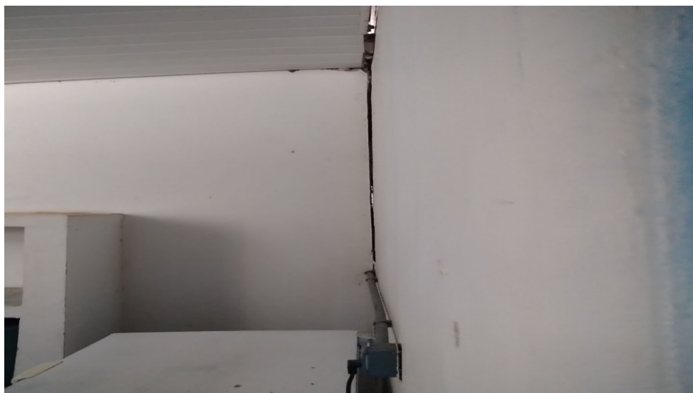
Imagem 06: Descolamento da parede da despensa com a parede da cozinha.
