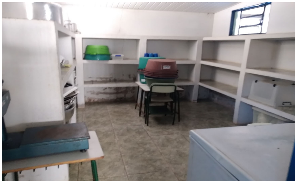
Imagem 05: Infiltração despensa.
