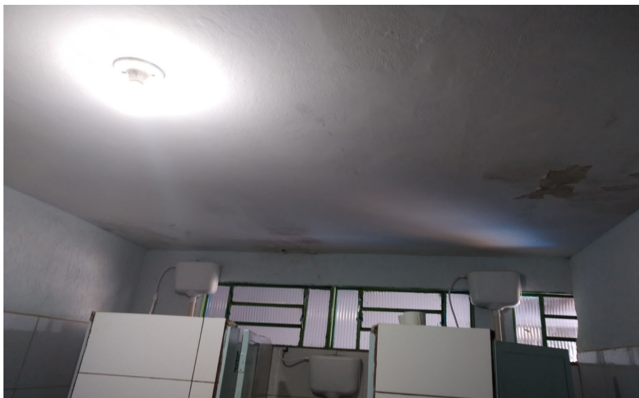
Imagem 02: Infiltração teto banheiro masculino.
