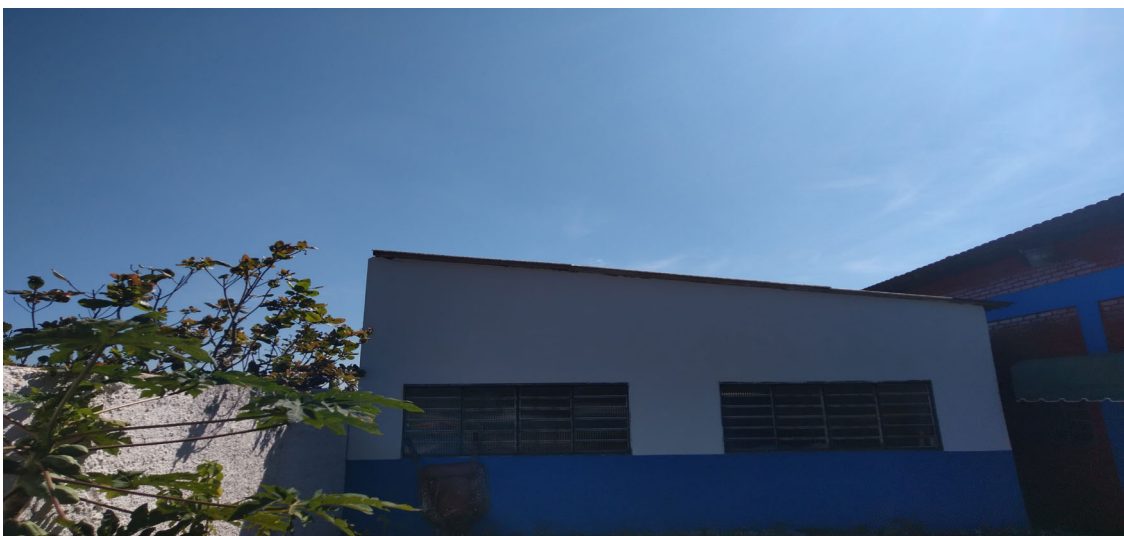
Imagem 01: Infiltração canto esquerdo telhado falta de beiral.
