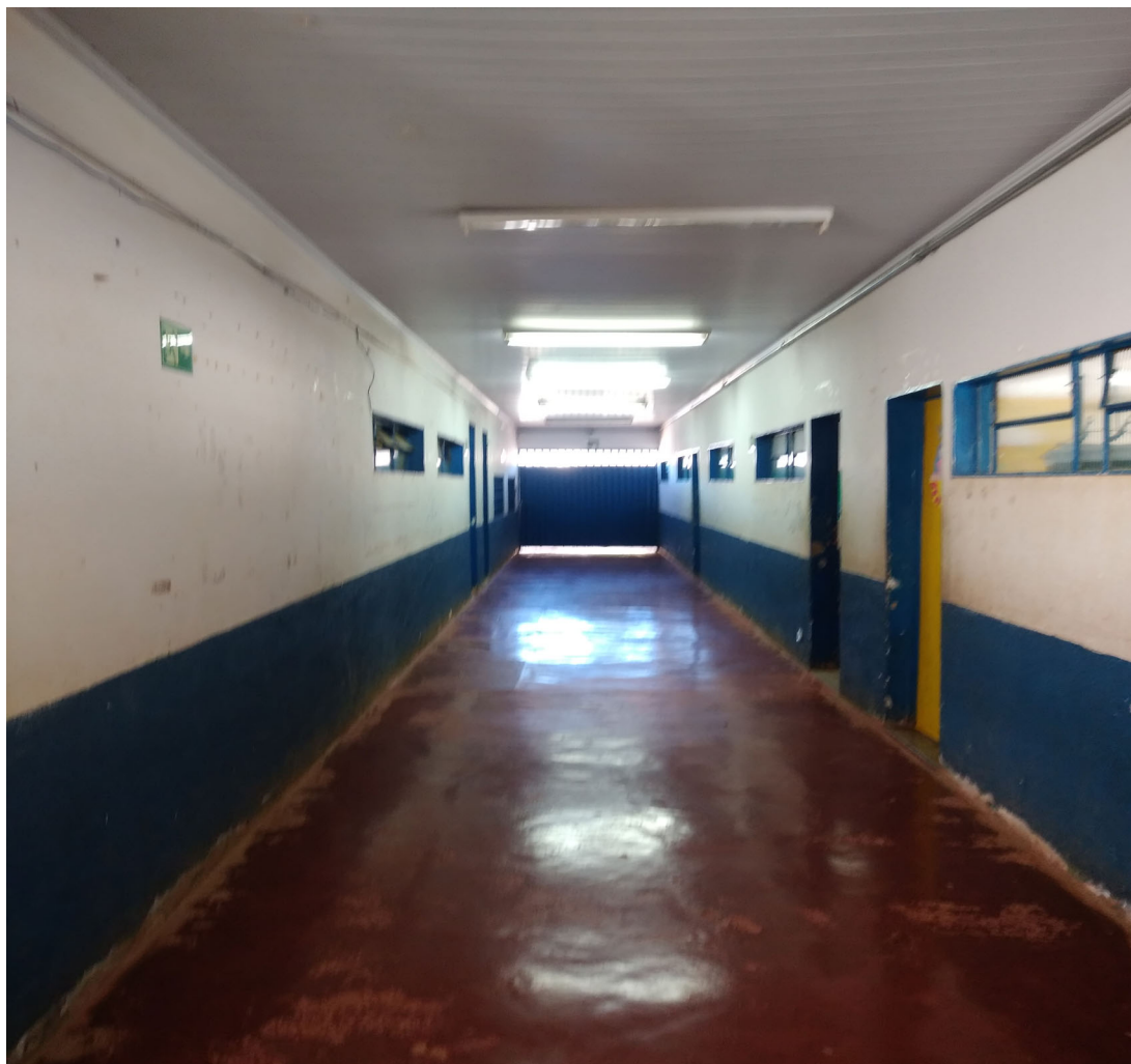
Imagem 03: Demolição de piso para construção de piso em granitina – pintura das paredes.
