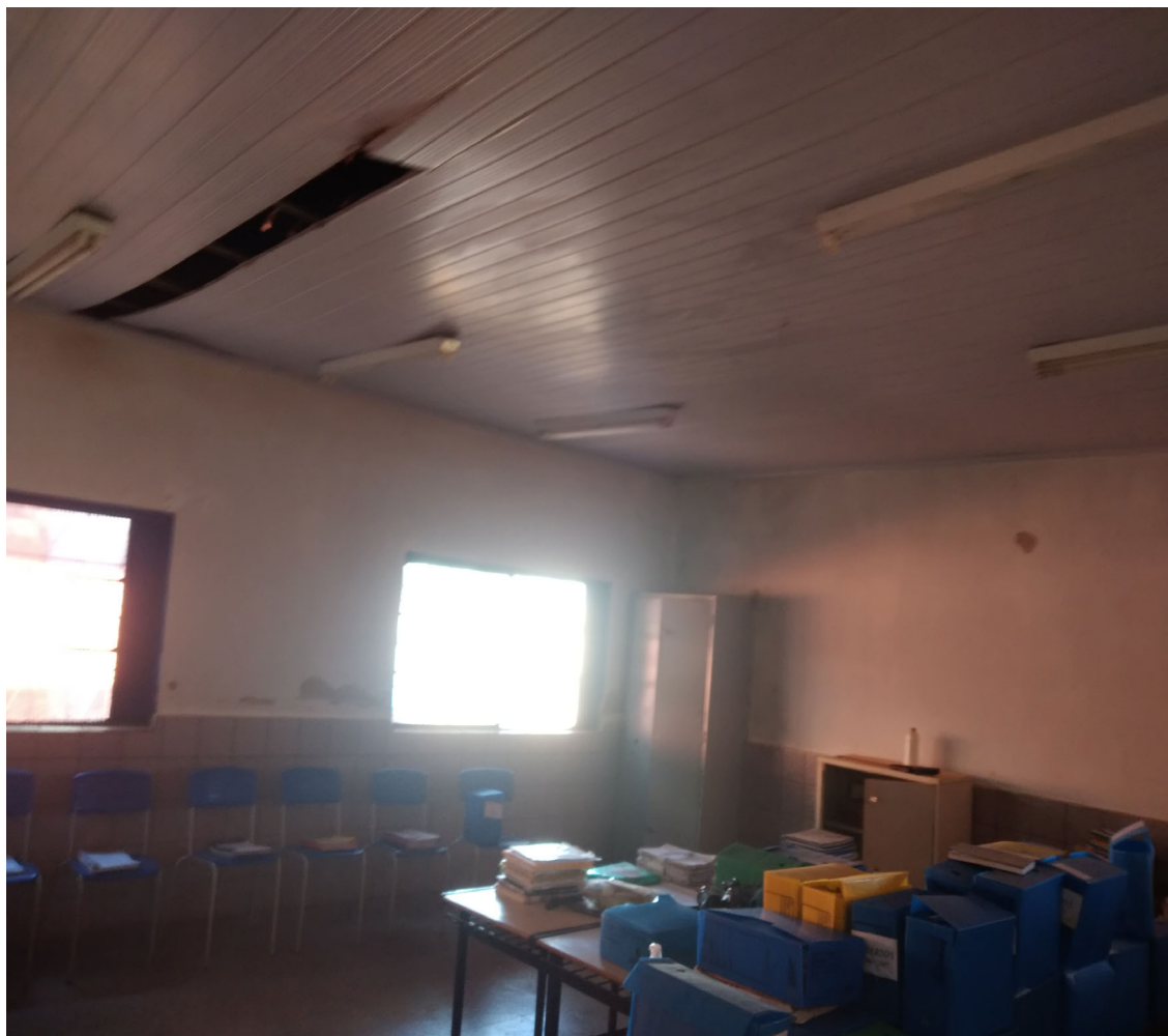
Imagem 08: Forro de pvc caindo – pintura das paredes.
