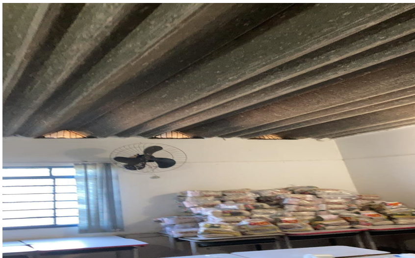
Imagem 02: Instalar forro PVC.
