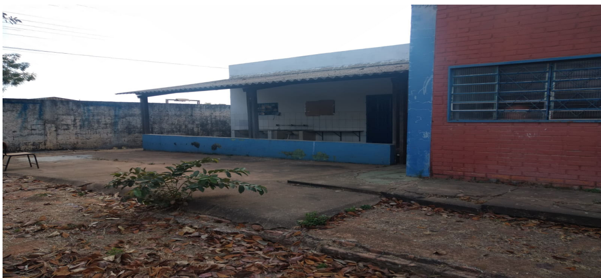
Demolição calçada para ampliação da cozinha.
