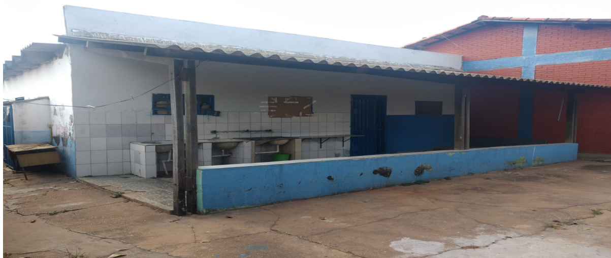
Vista da área de ampliação da cozinha.
