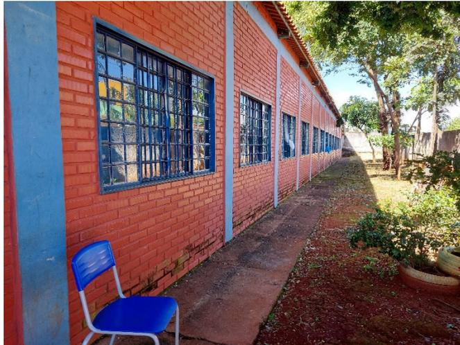
**Imagem 06: Exemplo de parede, pilar e viga**
