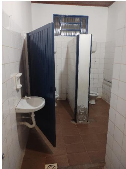
**Imagem 06: Exemplo de revestimento cerâmico a ser substituído**
