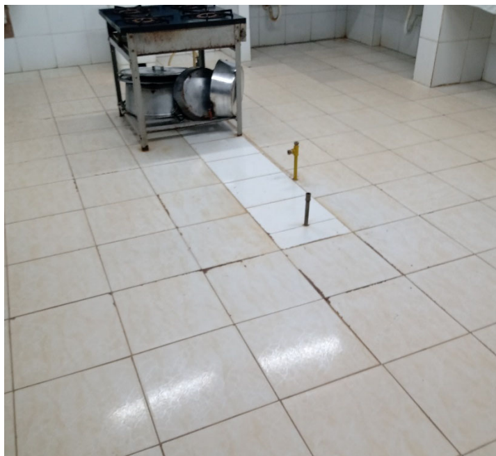
Imagem 03: Piso da cozinha.
