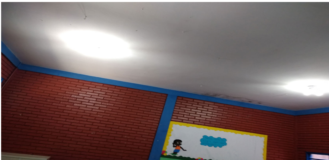
Imagem 08: Infiltração no teto da sala de aula (pintura).
