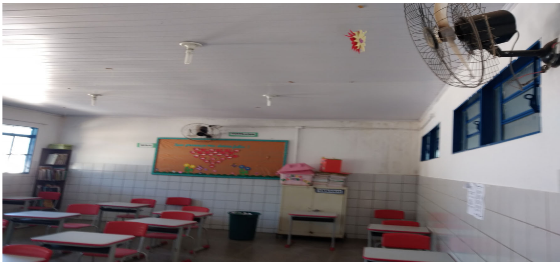
Imagem 10: Parede com infiltração.
