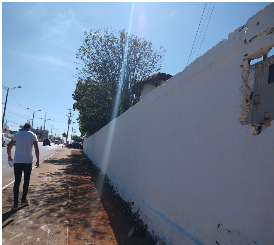
Imagem 02: Muro da escola.
