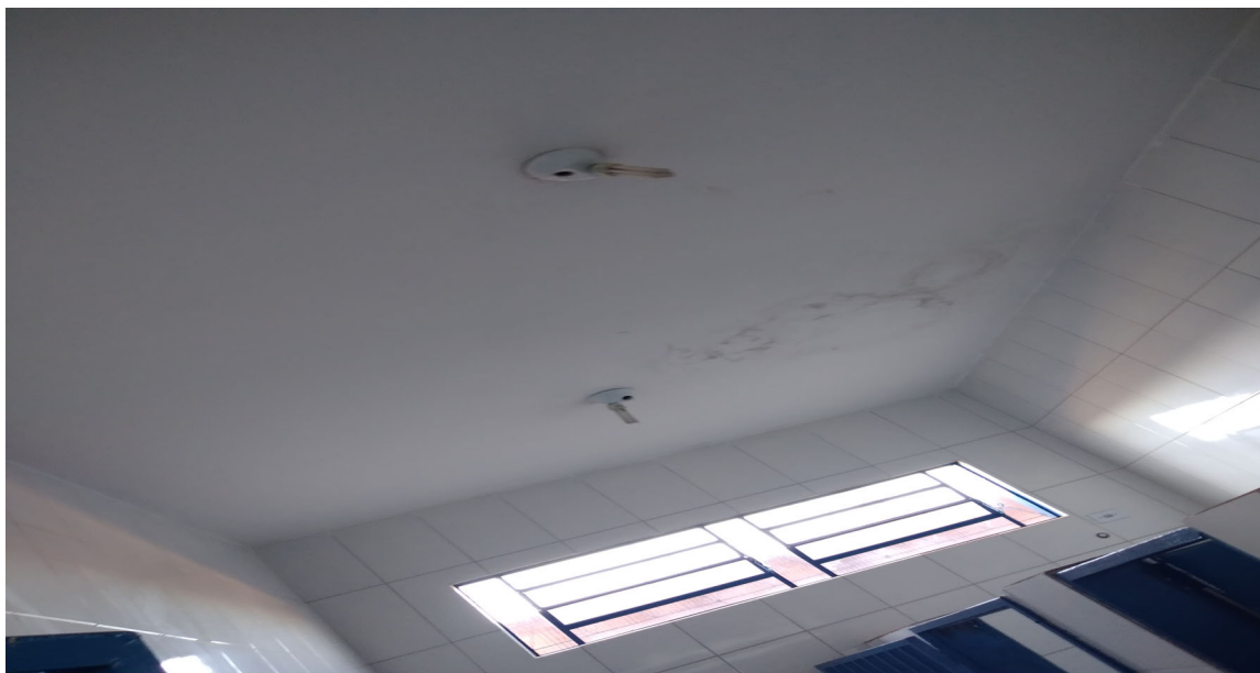
Imagem 11: Infiltração no teto do banheiro.
