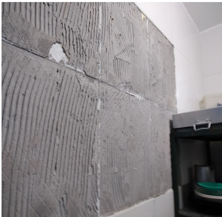
Imagem 03: Revestimento cerâmico arrancado (depósito).
