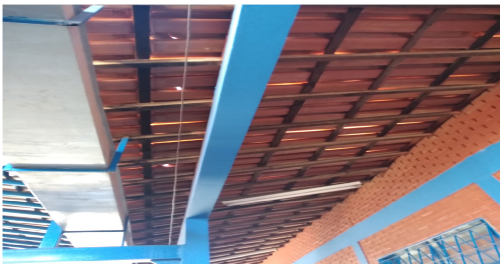
Imagem 07: Telhas quebradas pátio interno e circulação.
