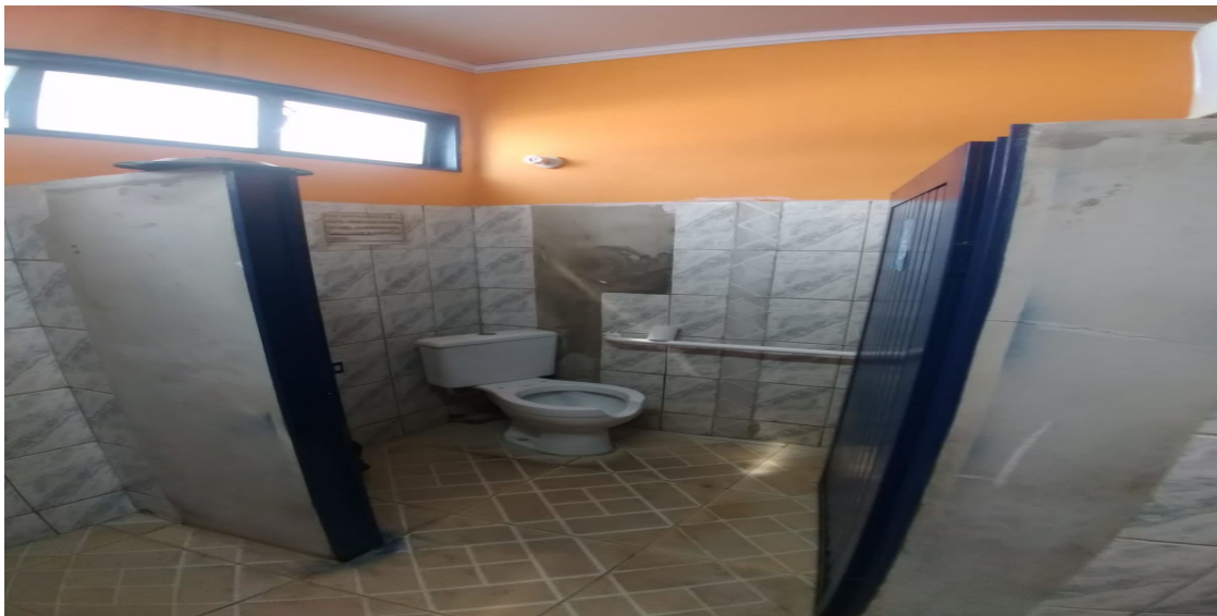
Imagem 09: Substituição de cerâmica.
