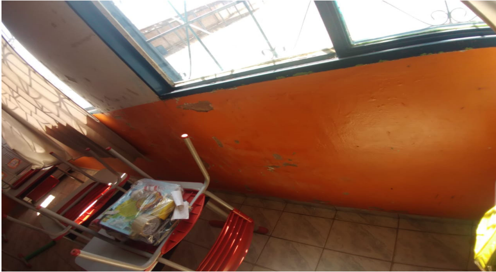
Imagem 03: Infiltração nas paredes a serem retiradas.
