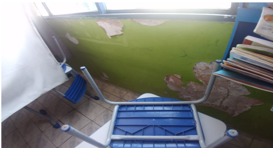
Imagem 02: Infiltração nas paredes a ser retiradas.
