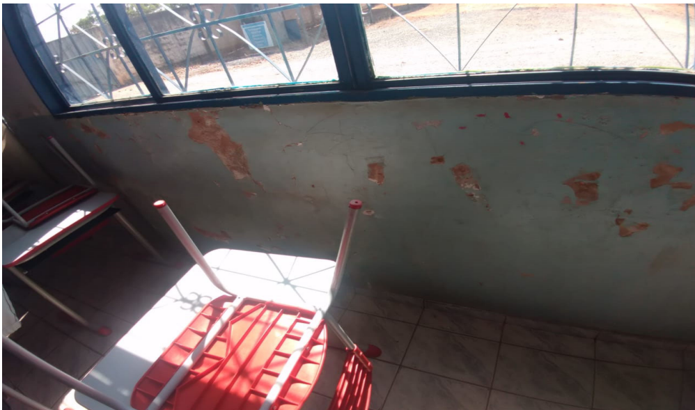
Imagem 04: Infiltração nas paredes a serem retiradas.
