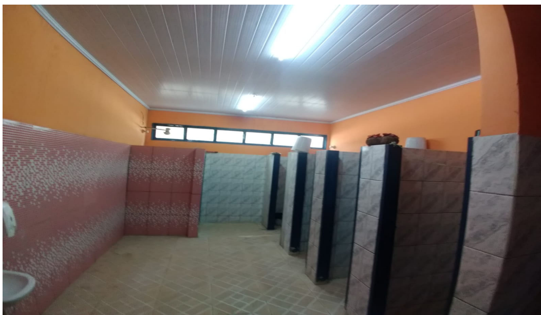
Imagem 08: Substituição do revestimento e das portas do box do banheiro – cerâmica vermelha não será demolida.
