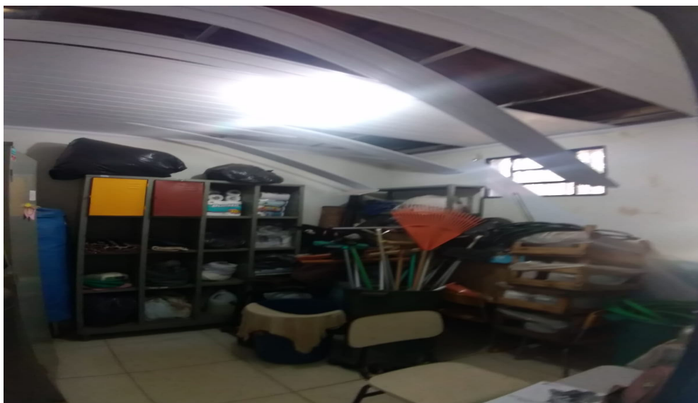
Imagem 01: Substituir forro de pvc.
