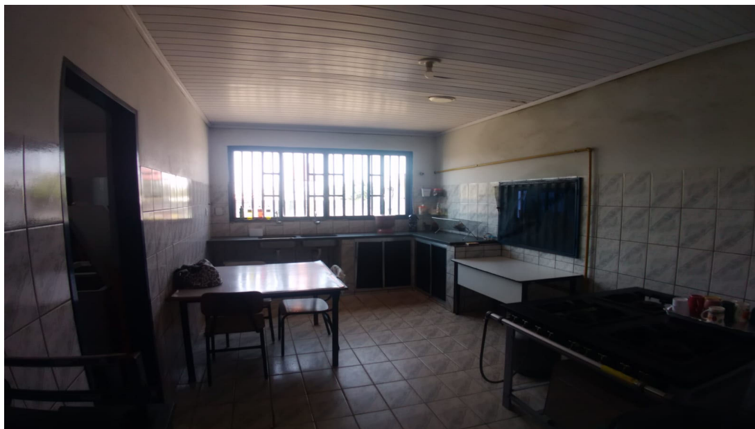
Imagem 06: Cozinha – executar piso em granitina, substituição do revestimento da parede.
