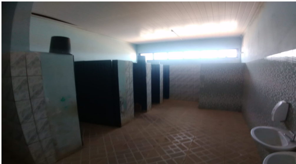
Imagem 07: Substituição do revestimento e das portas do box do banheiro – cerâmica verde não será demolida.
