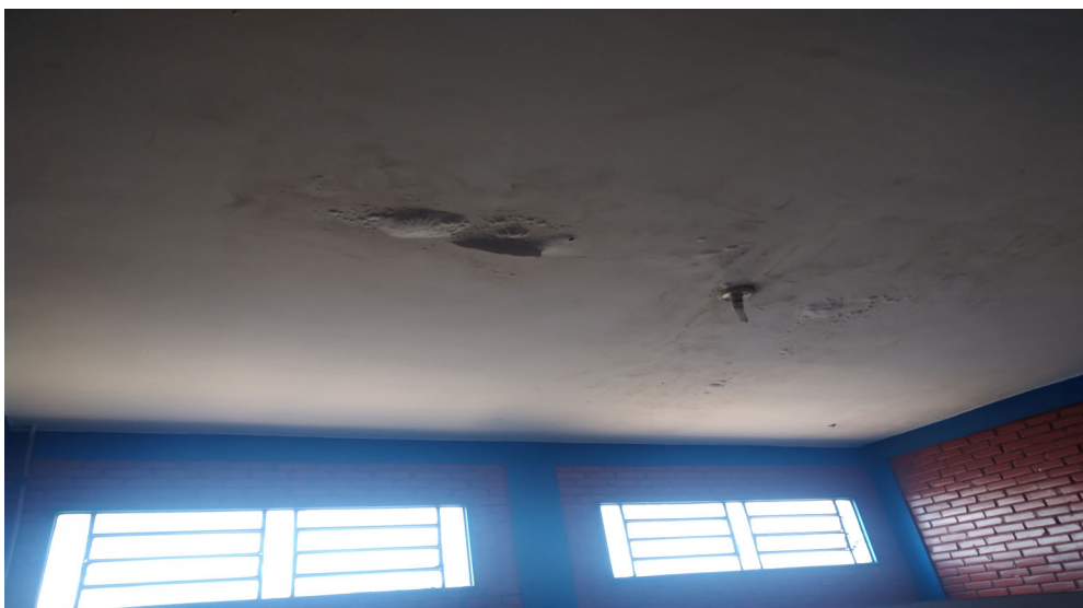
Imagem 07: Infiltração teto banheiro.
