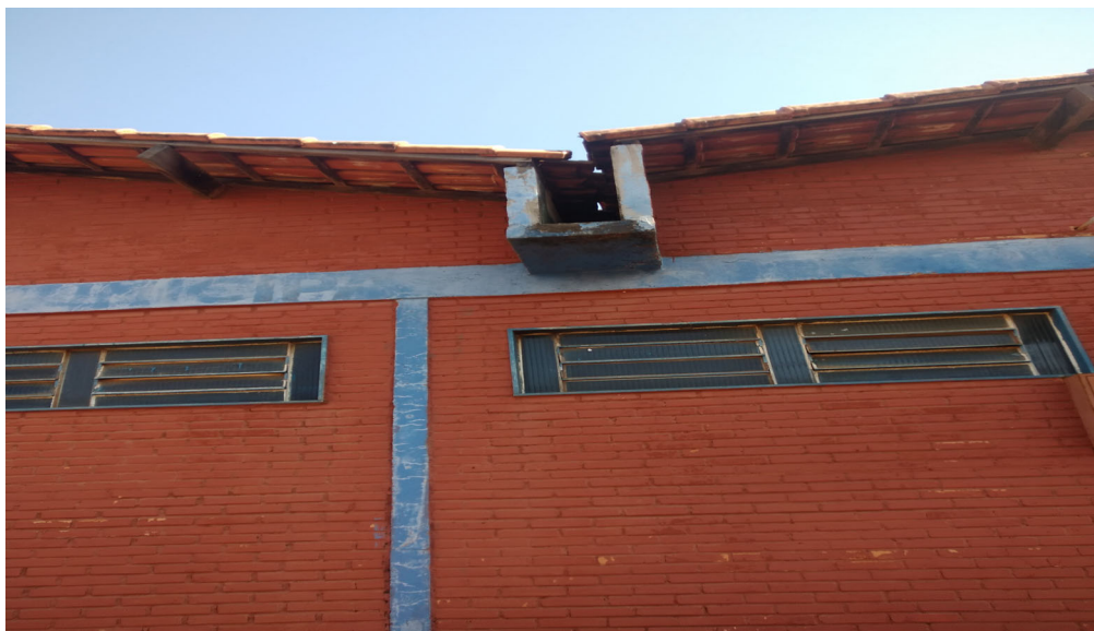
Imagem 10: Calha a ser impermeabilizada.
