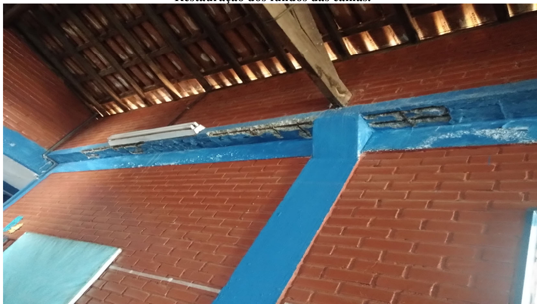
Imagem 04: Impermeabilização das calhas com manta asfáltica aluminizada e chapa Galvanizada Restauração dos fundos das calhas.
