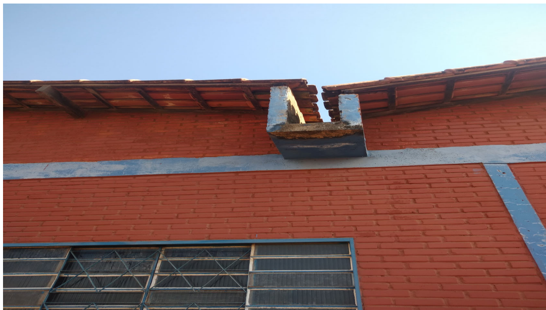
Imagem 09: Calha a ser impermeabilizada
