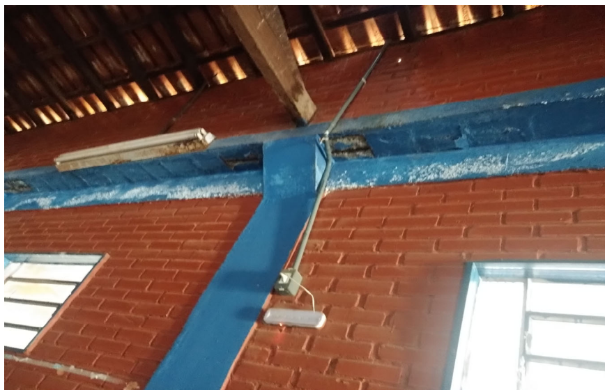
Imagem 02: Impermeabilização das calhas com manta asfáltica aluminizada e chapa Galvanizada Restauração dos fundos das calhas.
