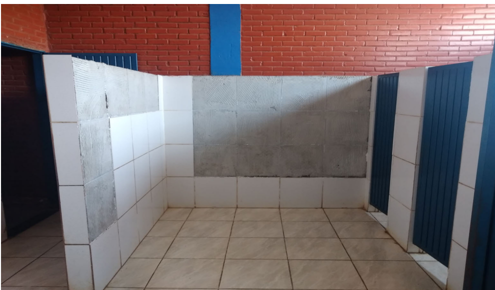
Imagem 08 - Banheiro – substituir revestimento parede
