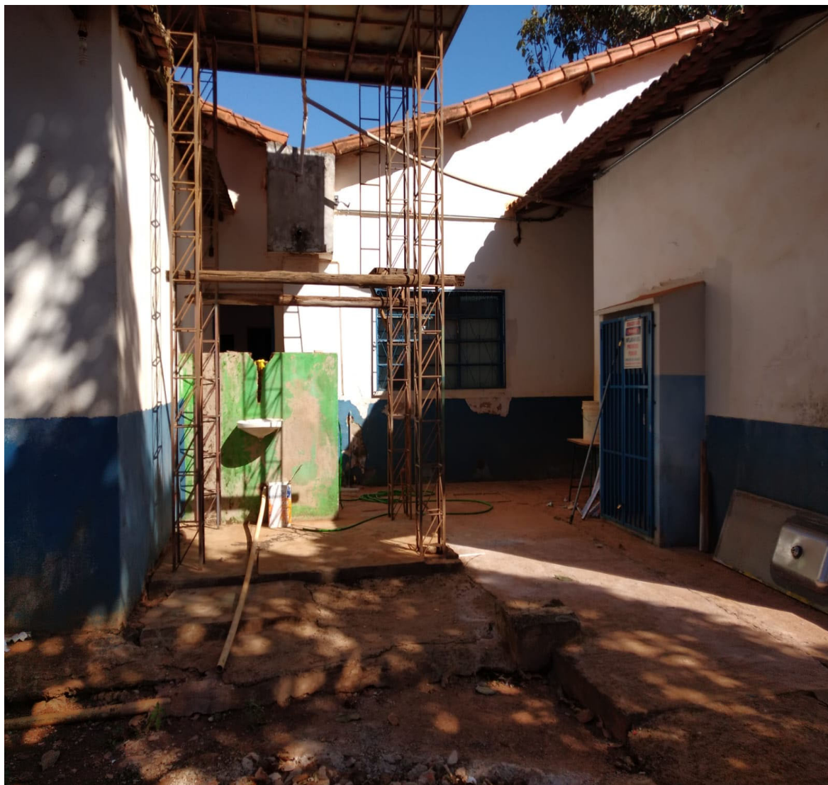
Imagem 07: Demolição e regularização de piso, demolição do tanque, demolição da central de gás.
