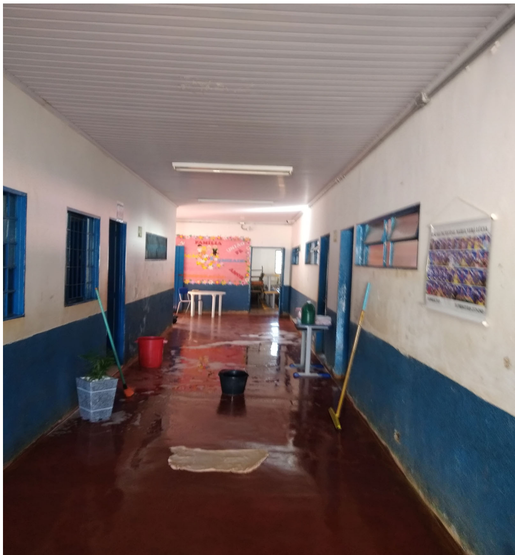
Imagem 01: Demolição de piso para construção de piso em granitina – pintura das paredes.
