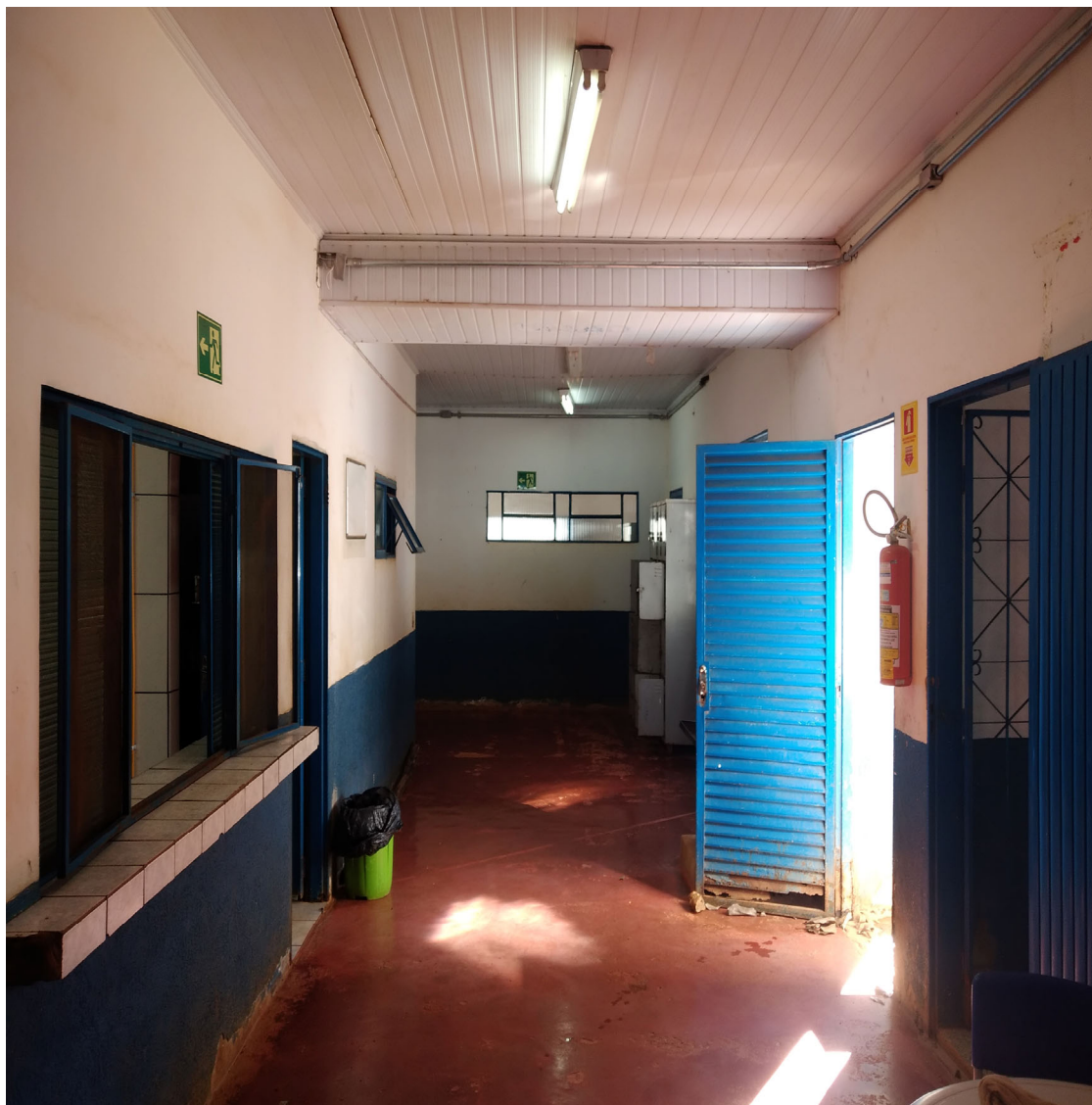
Imagem 02: Demolição de piso para construção de piso em granitina, substituição de porta.
