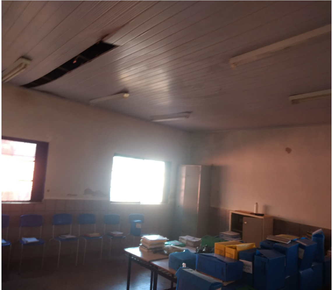
Imagem 08: Forro de pvc caindo – pintura das paredes.
