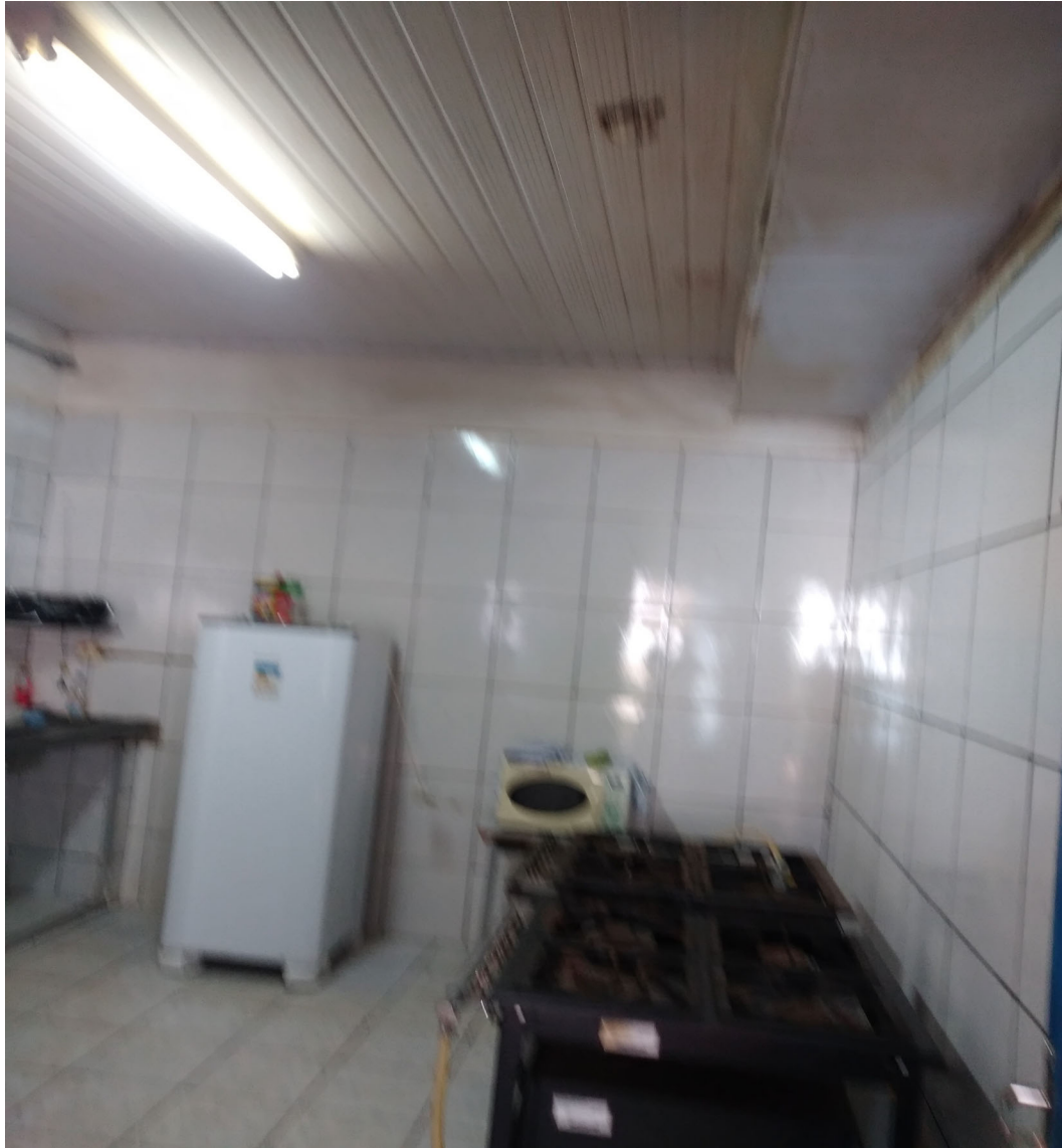
Imagem 10: Cozinha que será desativada por falta de ventilação e iluminação natural.
