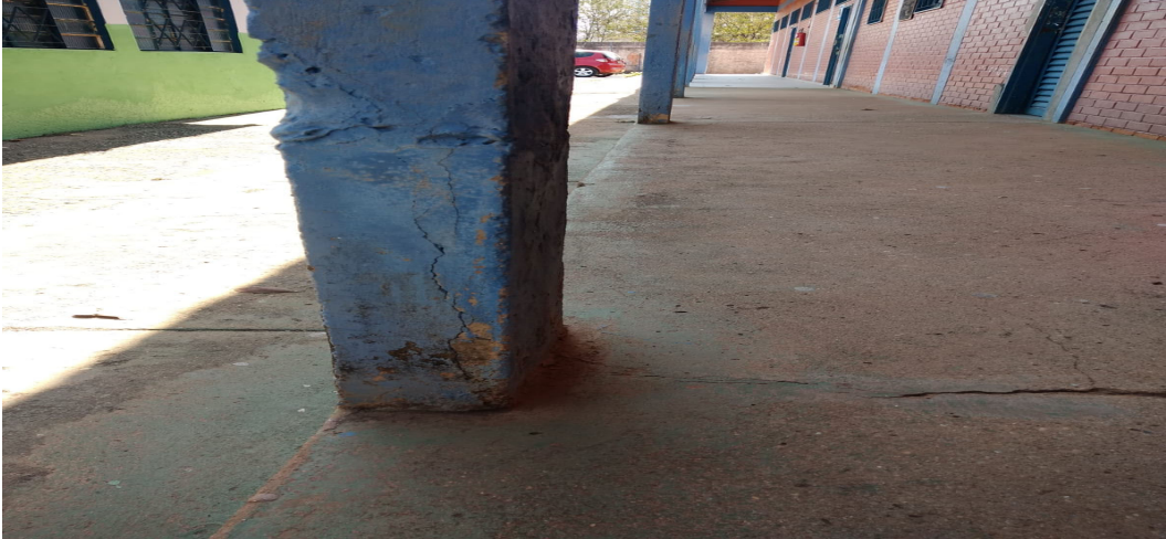
Pilar a ser restaurado
