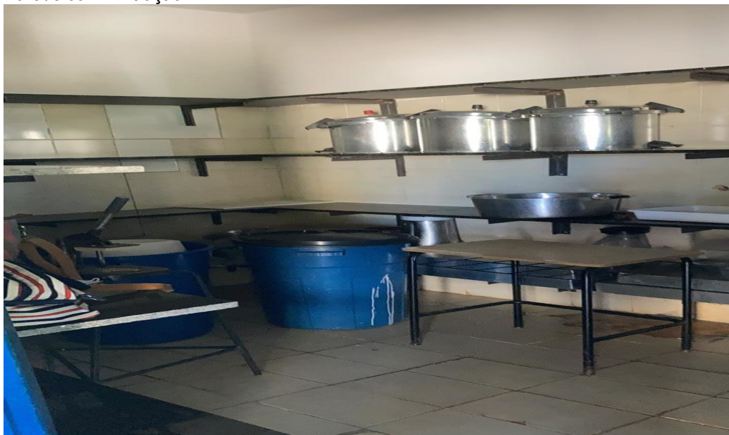
Cerâmica quebrada despensa
