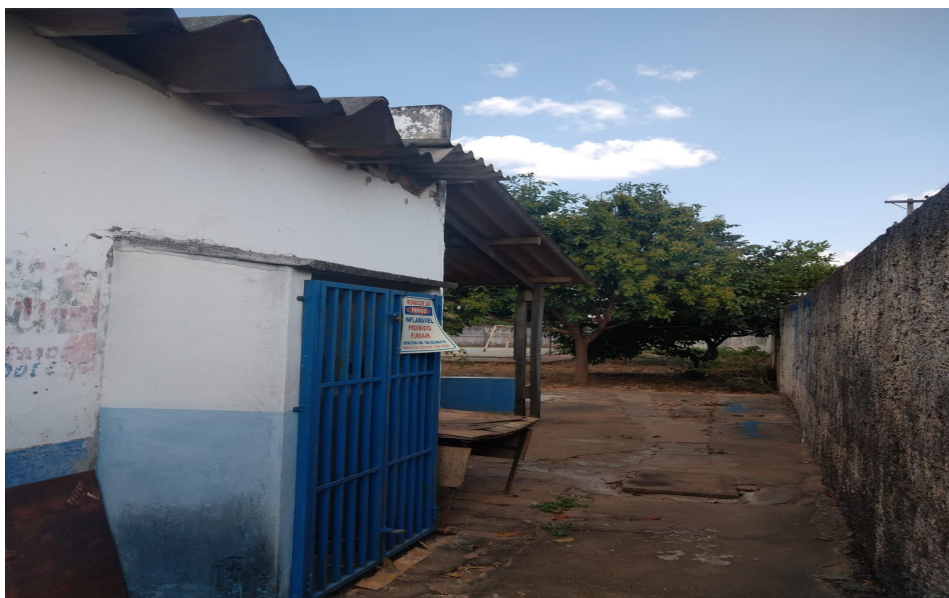
Demolição calçada devido à infiltração de esgoto (reconstrução do esgoto e da calçada).
