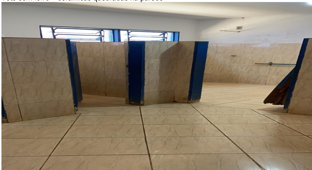
Box com portas quebradas e sem portas (portas de madeira)
