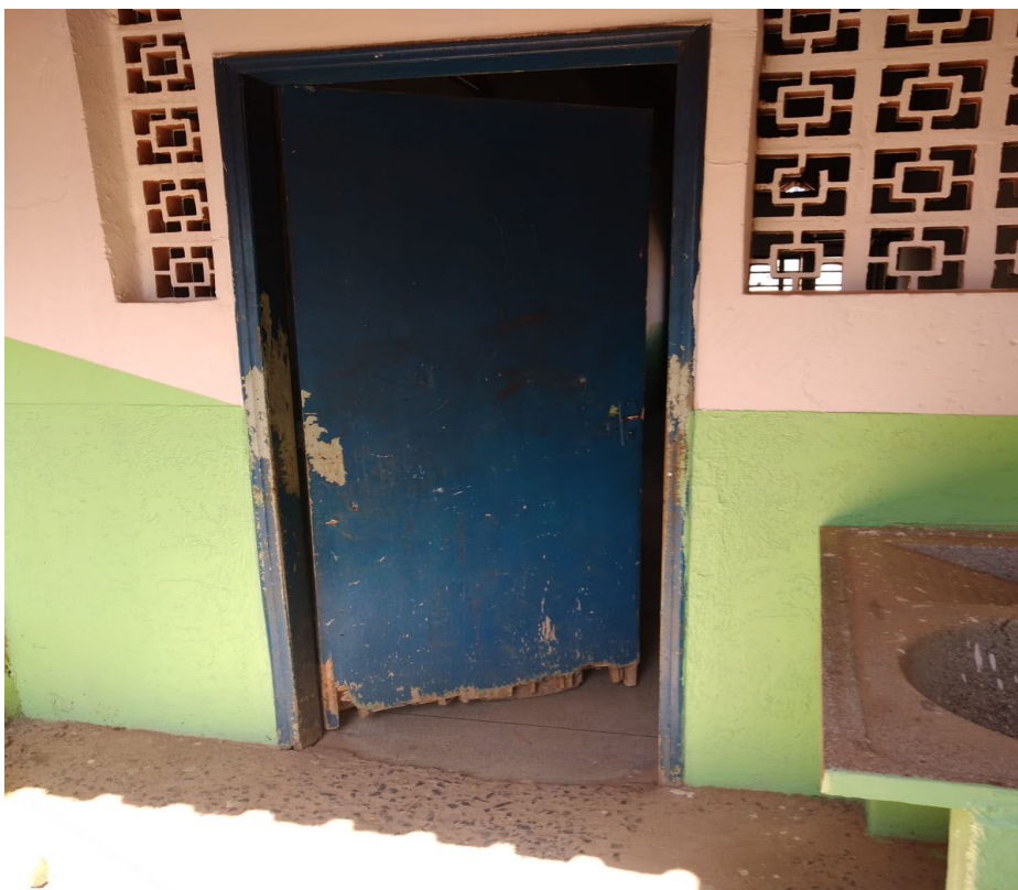
Porta danificada – substituir porta
