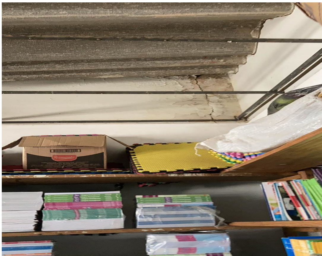
Imagem 03: Sem forro pvc, com infiltração.
