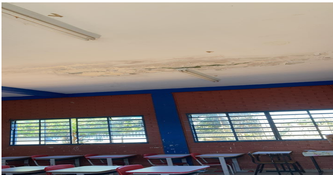
Infiltração teto
