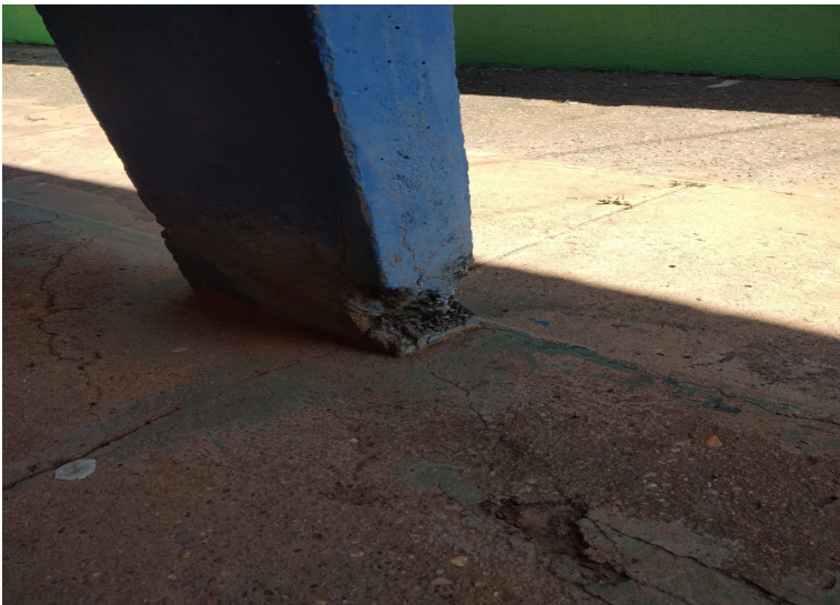
Pilar a ser restaurado
