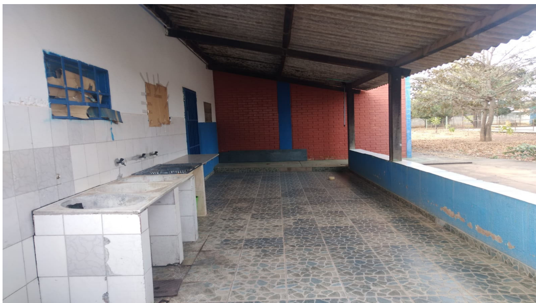
Demolição do piso, parede, cobertura, mureta, para ampliação da cozinha
