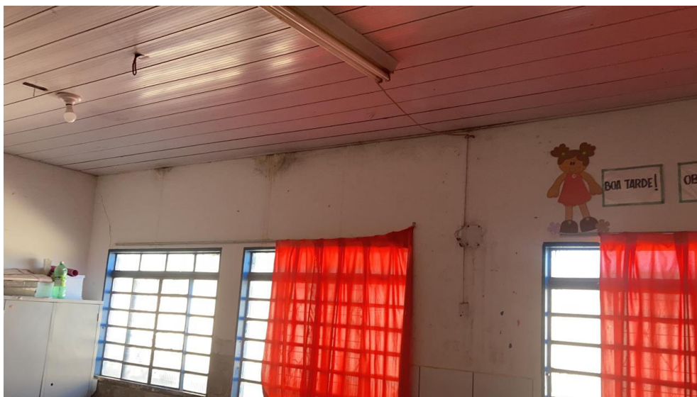
Parede com infiltração
