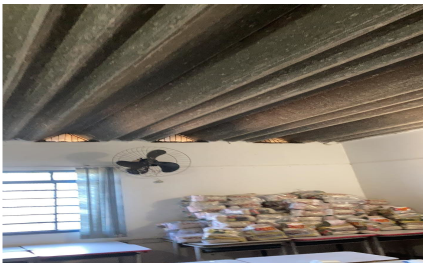
Imagem 02: Instalar forro PVC.
