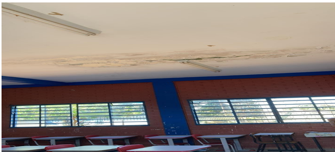
Infiltração teto
