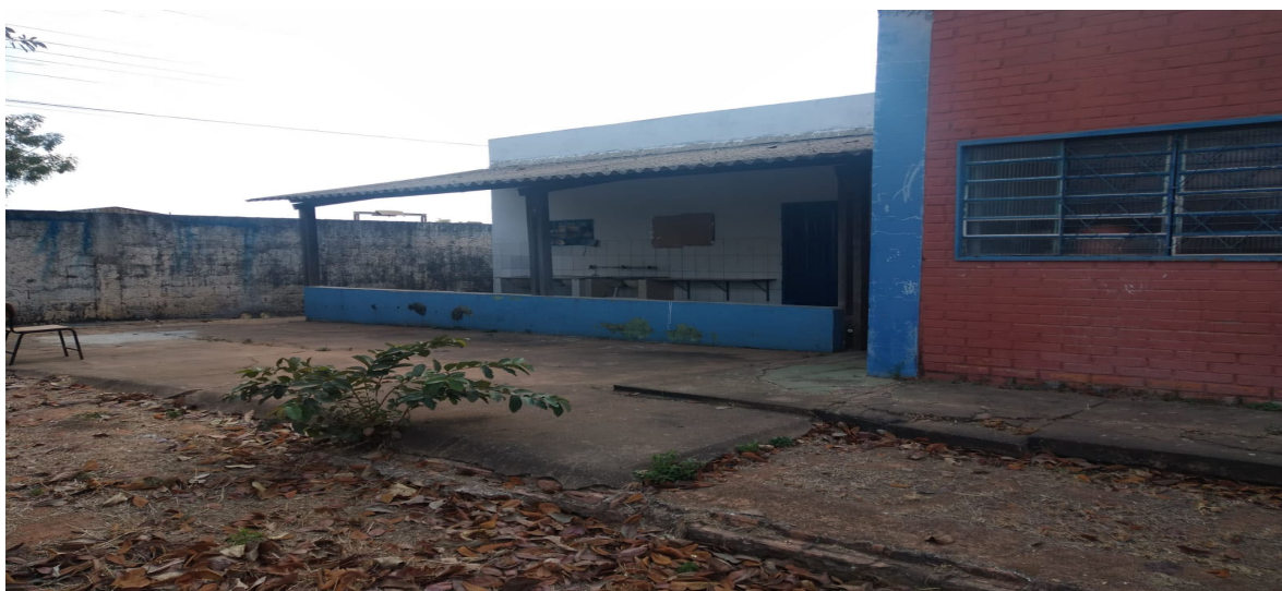
Demolição calçada para ampliação da cozinha.
