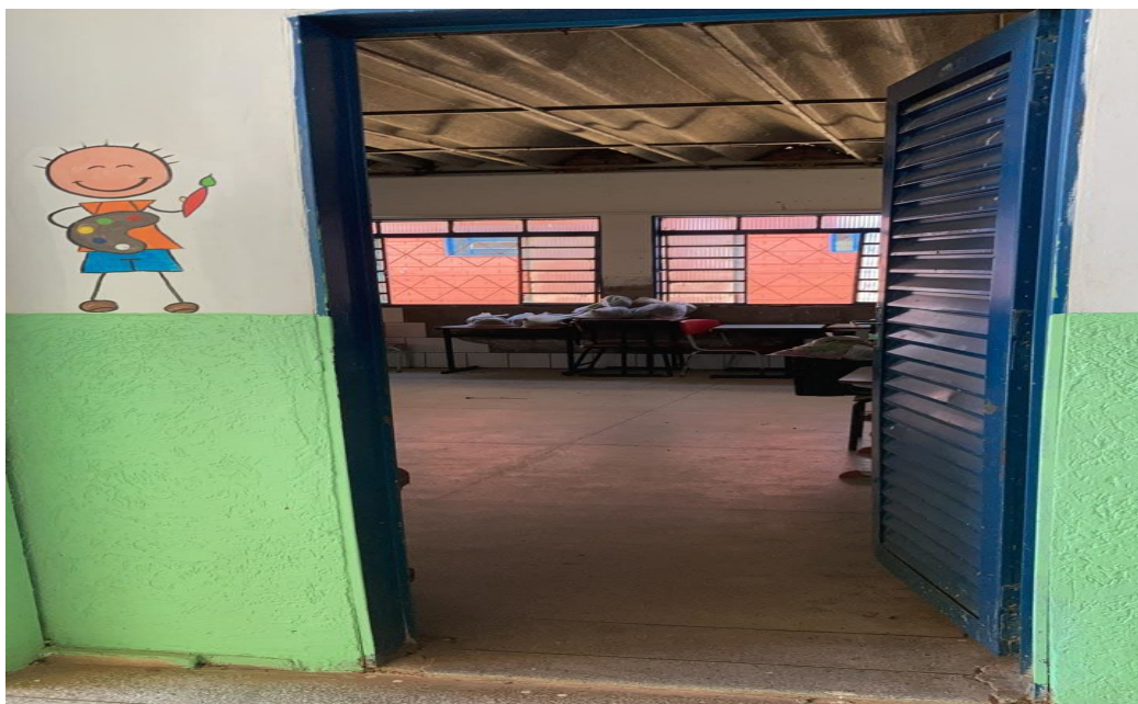
Teto sem forro – cerâmicas quebradas na parede
