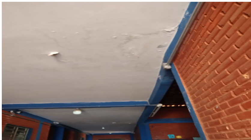
Imagem 01: Infiltração no teto.
