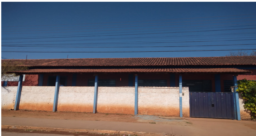
Imagem 11: Instalação de calha entre os telhados para evitar o transbordamento de águas no telhado mais baixo
