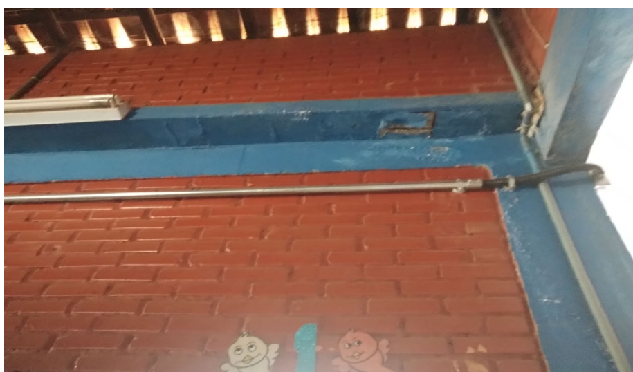
Imagem 05: Impermeabilização das calhas com manta asfáltica aluminizada e chapa Galvanizada Restauração dos fundos das calhas.
