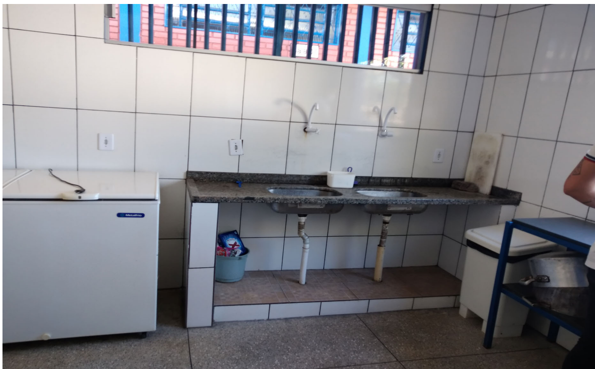
Imagem 12: Instalar sifões na pia.
