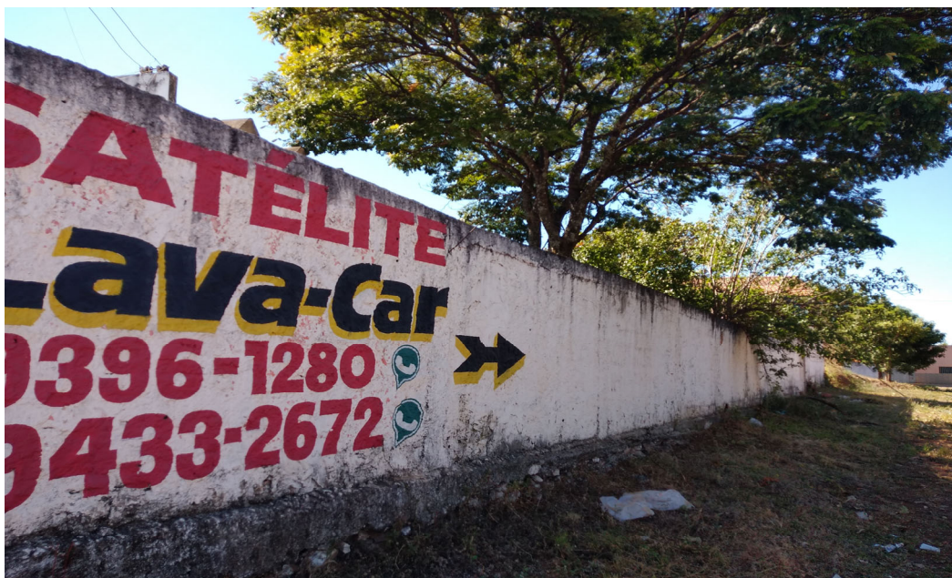
Imagem 04: Muro da escola.
