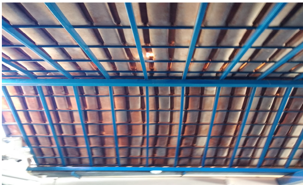
Imagem 06: Telhado da escola.
